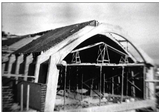
Figs. 10 y 11: Ala de externos. Solución estructural de la cubierta y construcción de los lunetos de la bóveda.
