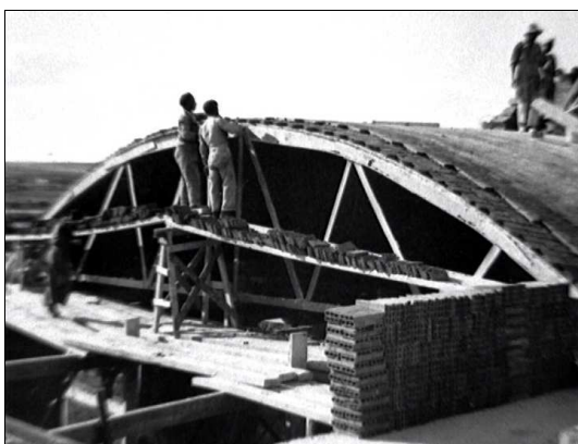
Figs. 3 y 4: Ejecución de la cubierta de los talleres siguiendo el método descrito en Bóvedas tabicadas .
