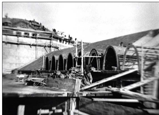
Figs. 10 y 11: Ala de externos. Solución estructural de la cubierta y construcción de los lunetos de la bóveda.
