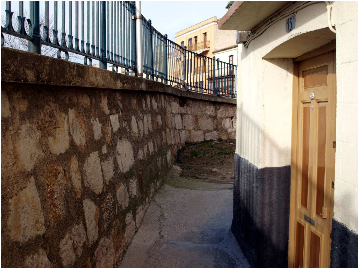
Figura 11: Rampas de acceso al puente. Estado actual.
