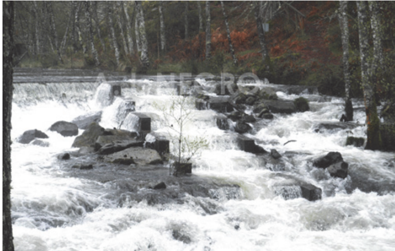
Figura 18. Escala de peces de estanques sucesivos en un azud del río Mera (Lugo).
