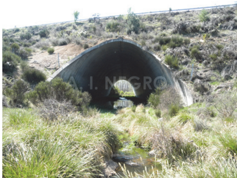
Figura 8. Paso inferior de fauna en la autovía A-52, entre Mombuey y Puebla de Sanabria (Zamora). Por centro de él circula un arroyo.
