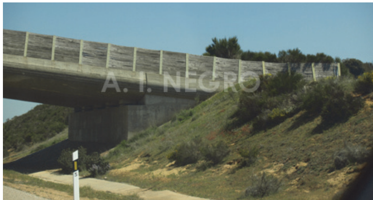
Figura 7. Pasos de fauna superiores en la autovía A-66 entre Benavente y León. Abajo se muestra un detalle del extremo de uno de estos pasos, con forma de embudo y superficie cubierta de vegetación autóctona para atraer a los animales hacia el paso. Los laterales se tapan con materiales naturales (madera) para que los animales no se asusten al ver el tráfico y para disminuir el ruido.
