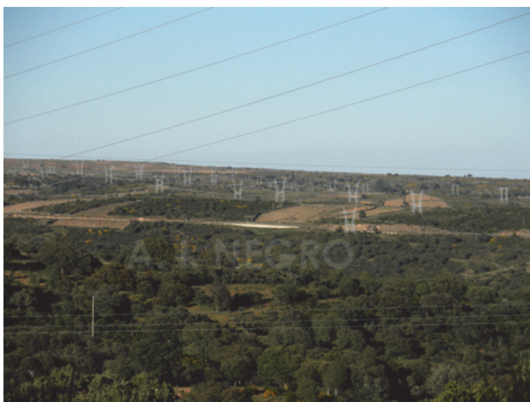
Figura 23. Arriba: panorámica de una cuenca visual muy llana en la zona de Montamarta (Zamora) en la que lo que atrae la atención es la silueta de un parque eólico. También destacan algunas torres de alta tensión y los cables. Abajo: panorámica de una zona de Los Arribes del Duero de Zamora próxima a la presa de Villalcampo. El paisaje aparece salpicado por todas partes de torres de alta tensión.
