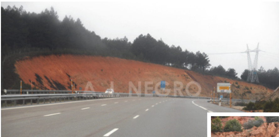
Figura 10. Talud completamente desnudo cuyo color contrasta con el verde oscuro de los pinos de parte superior, en la autovía A-6, Puerto de Manzanal, León. La naturaleza del terreno y las pendientes dificultan el crecimiento de la vegetación. En estos taludes el agua de escorrentía produce grandes cárcavas (derecha).
