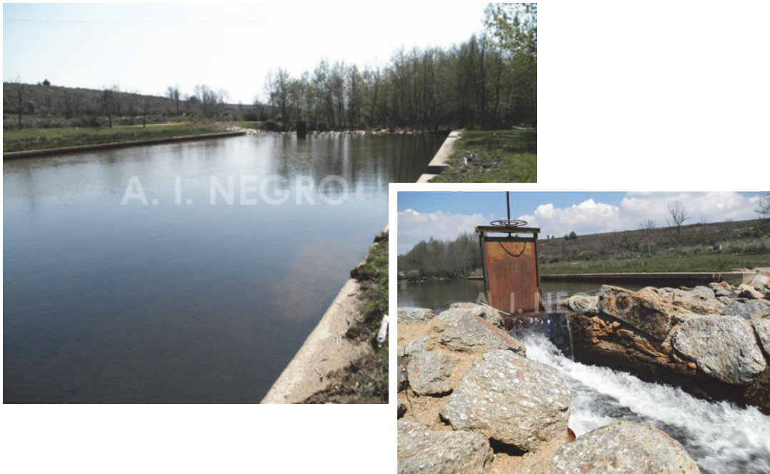
Figura 22. Piscina fluvial en el río Negro a su paso por las proximidades de Rosinos de la Requejada (Zamora). A la derecha se observa un detalle del azud y la compuerta. Aunque el azud cuenta con una rampa rústica para facilitar el paso de los peces, la construcción de la piscina ha modificado el cauce del río en ese punto.
