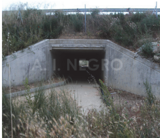
Figura 9. Paso inferior de fauna en la autovía A-66, entre Zamora y Salamanca. En este punto existe un pequeño arroyo, seco en el momento de tomar la foto. Se observa a la izquierda una plataforma para favorecer el paso de pequeños animales en caso de que el nivel del agua del arroyo suba.
