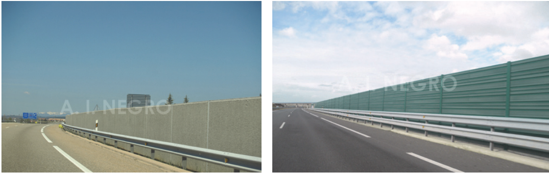
Figura 14. Pantalla acústica de hormigón en la autovía A-66 en las proximidades de León (izquierda) y pantalla acústica de módulos metálicos en la autovía A-66, entre Zamora y Salamanca.
