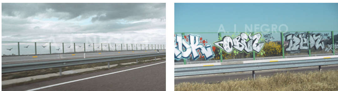
Figura 13. Pantallas acústicas de módulos transparentes en la autovía A-66, tramo Zamora-Salamanca. Para evitar que las aves choquen con las pantallas suelen tener algún dibujo, frecuentemente la silueta de un ave (izquierda). La mayor intervisibilidad que se consigue con estas pantallas es muy a menudo inutilizada por los actos vandálicos (derecha).
