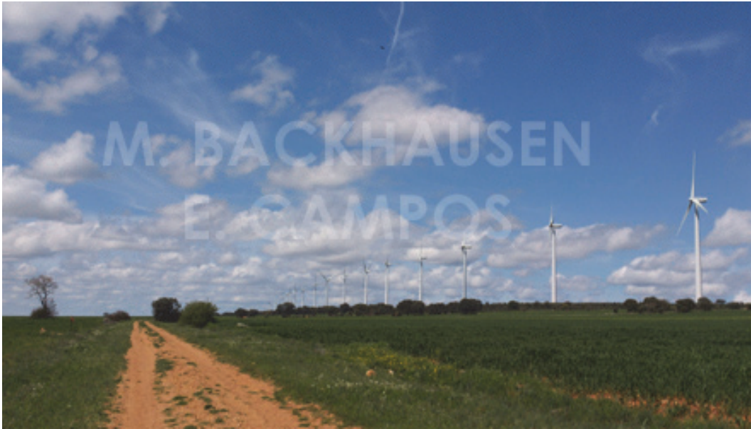
Figura 24. Los parques eólicos suelen tener una configuración en línea, como se observa en este parque de la zona de Montamarta (Zamora).
