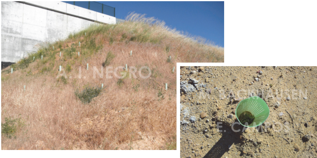
Figura 12. Labores de revegetación en un talud y detalle de una plántula con un protector para evitar el ataque de herbívoros.
