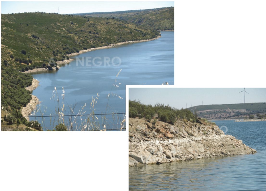
Figura 20. Panorámica del embalse de Villalcampo (Zamora, río Duero) en un momento en que era notoria la banda árida (arriba). A la derecha se muestra un detalle de la banda árida en el embalse de Ricobayo (Zamora, río Esla). Las fluctuaciones continuas en el nivel del agua impiden el establecimiento tanto de vegetación terrestre como acuática.
