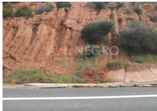
Figura 10. Talud completamente desnudo cuyo color contrasta con el verde oscuro de los pinos de parte superior, en la autovía A-6, Puerto de Manzanal, León. La naturaleza del terreno y las pendientes dificultan el crecimiento de la vegetación. En estos taludes el agua de escorrentía produce grandes cárcavas (derecha).
