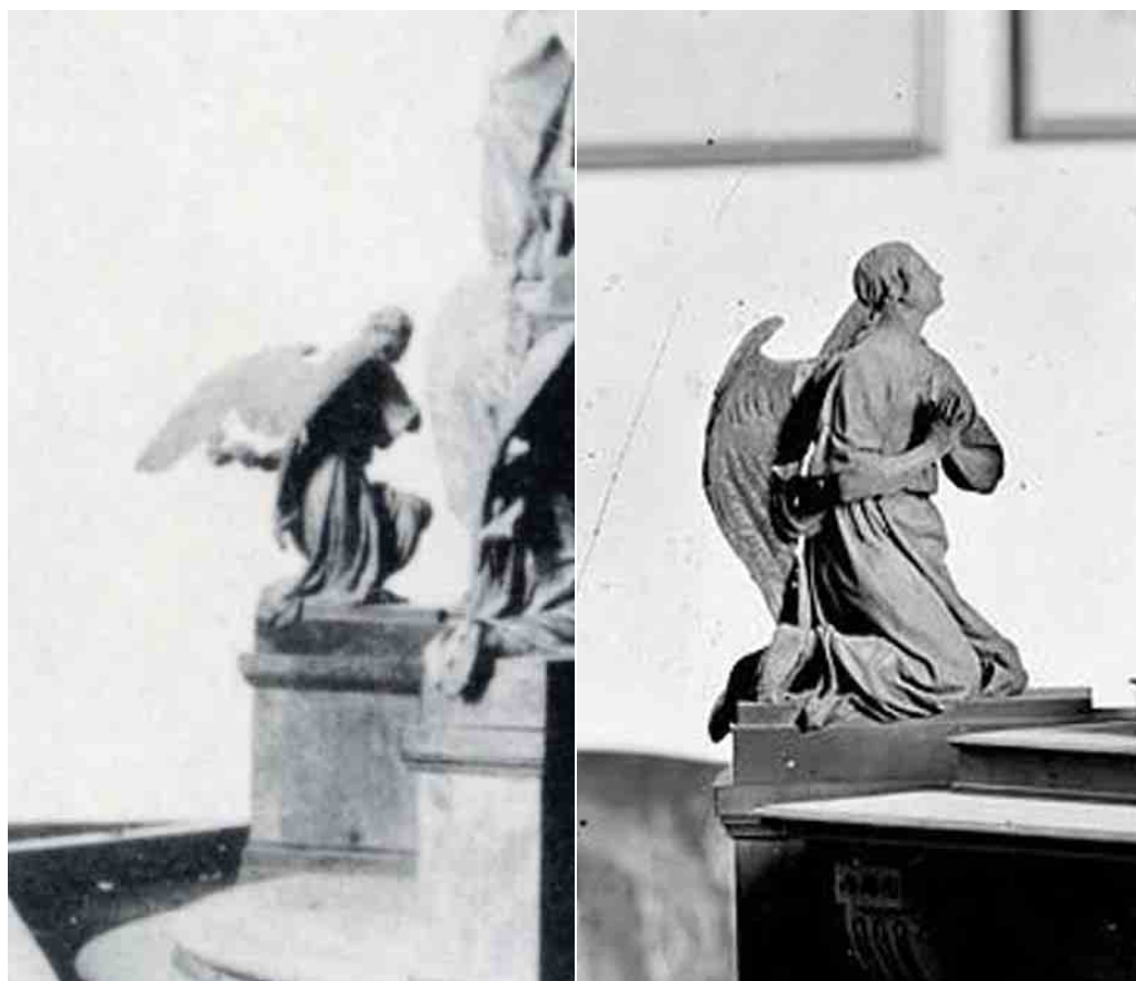
Dos de los ángeles que actualmente faltan.
