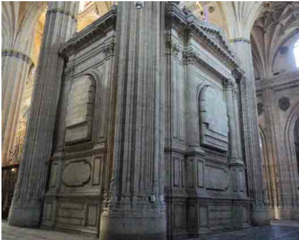
Muros de la capilla mayor desde el deambulatorio.
