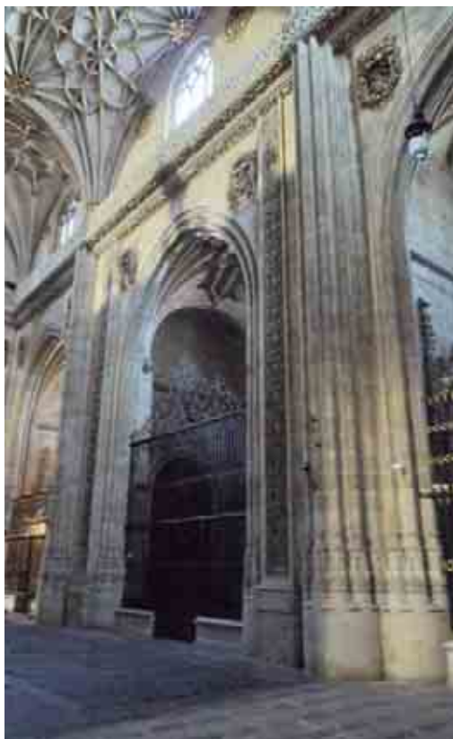
Muros de la capilla del Cristo de las Batallas.
