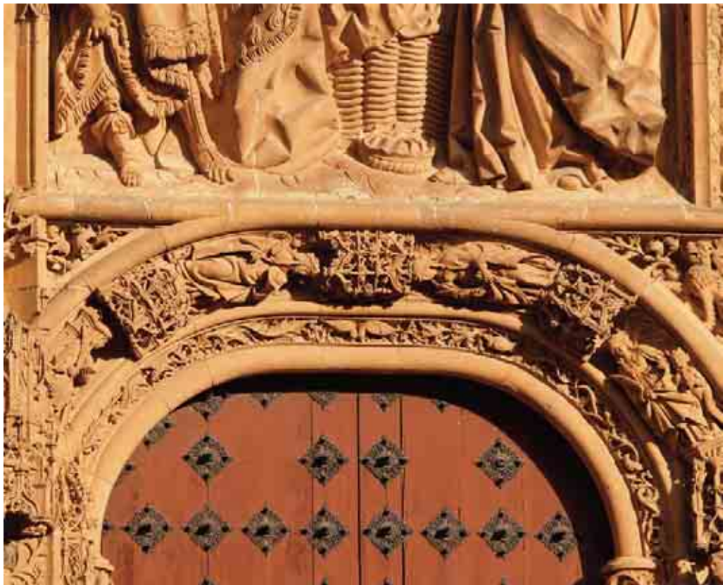
Detalle de la arquivolta del vano de acceso. Portada occidental.
