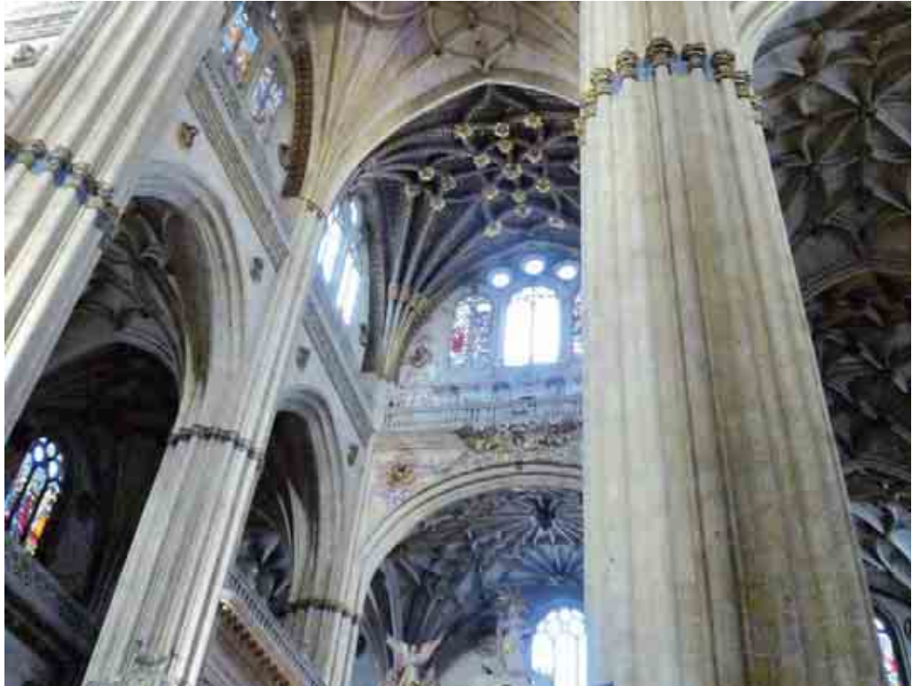
Bóveda de la Capilla Mayor.
