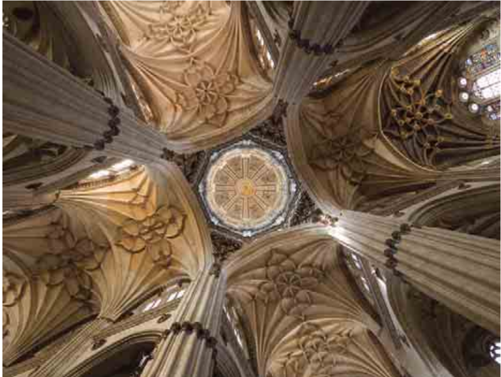
Bóvedas de la nave mayor, del crucero y cúpula de la catedral. La bóveda de mayor ornamentación se corresponde con la actual capilla mayor. En el proyecto de los Churriguera actuaba como “dosel” del tabernáculo.
