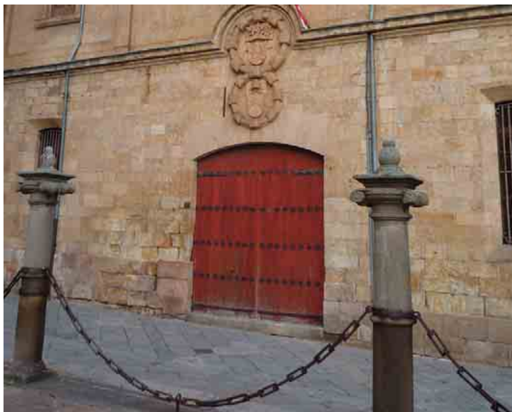
Puerta de las Cadenas de las Escuelas. Aspecto actual desde el atrio de la Catedral.
