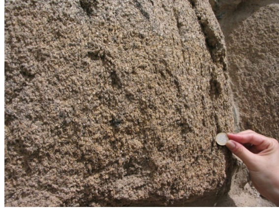
Figura 1.9. Pérdida de materia en un bloque de granito del Puente Romano, dándole un aspecto redondeado, como ocurre en la naturaleza.
