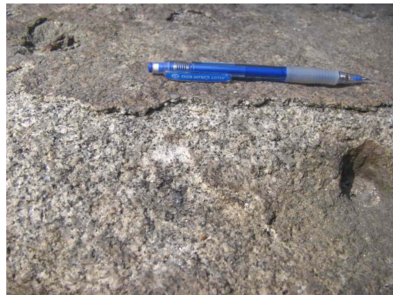
Figura 1.17. Pátina sobre un bloque de granito en el Puente Romano.
