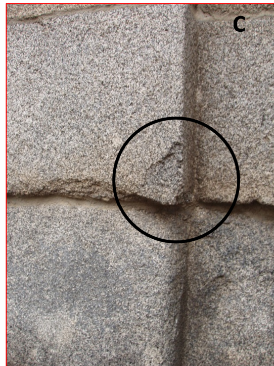
Figura 6.3. Lugar de toma de la muestra CUW en la Portada Principal de la Catedral Vieja de Salamanca. A: Vista de la puerta con las dos columnas donde se ha muestreado (1 y 2). B: Detalle de la columna 1. C: Lugar exacto de toma de la muestra CUW en la columna 2.
