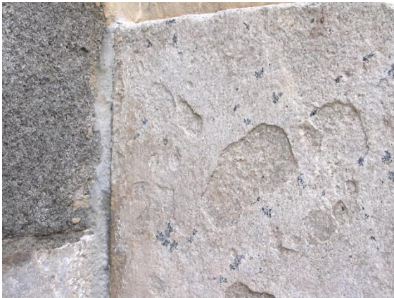
Figura 1.10. Desplacaciones en granito de Martinamor. Portada principal de la Catedral Vieja.
