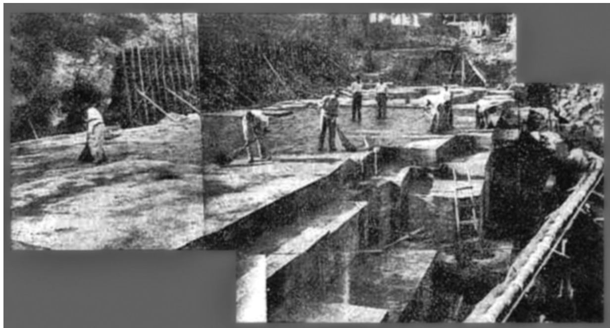
FIG. 8. Imagen de los trabajos realizados en el entorno de los manantiales para adecuar la captación de las aguas y construir el edificio provisional del balneario (Acciaiuoli, 1943-46: 120).
