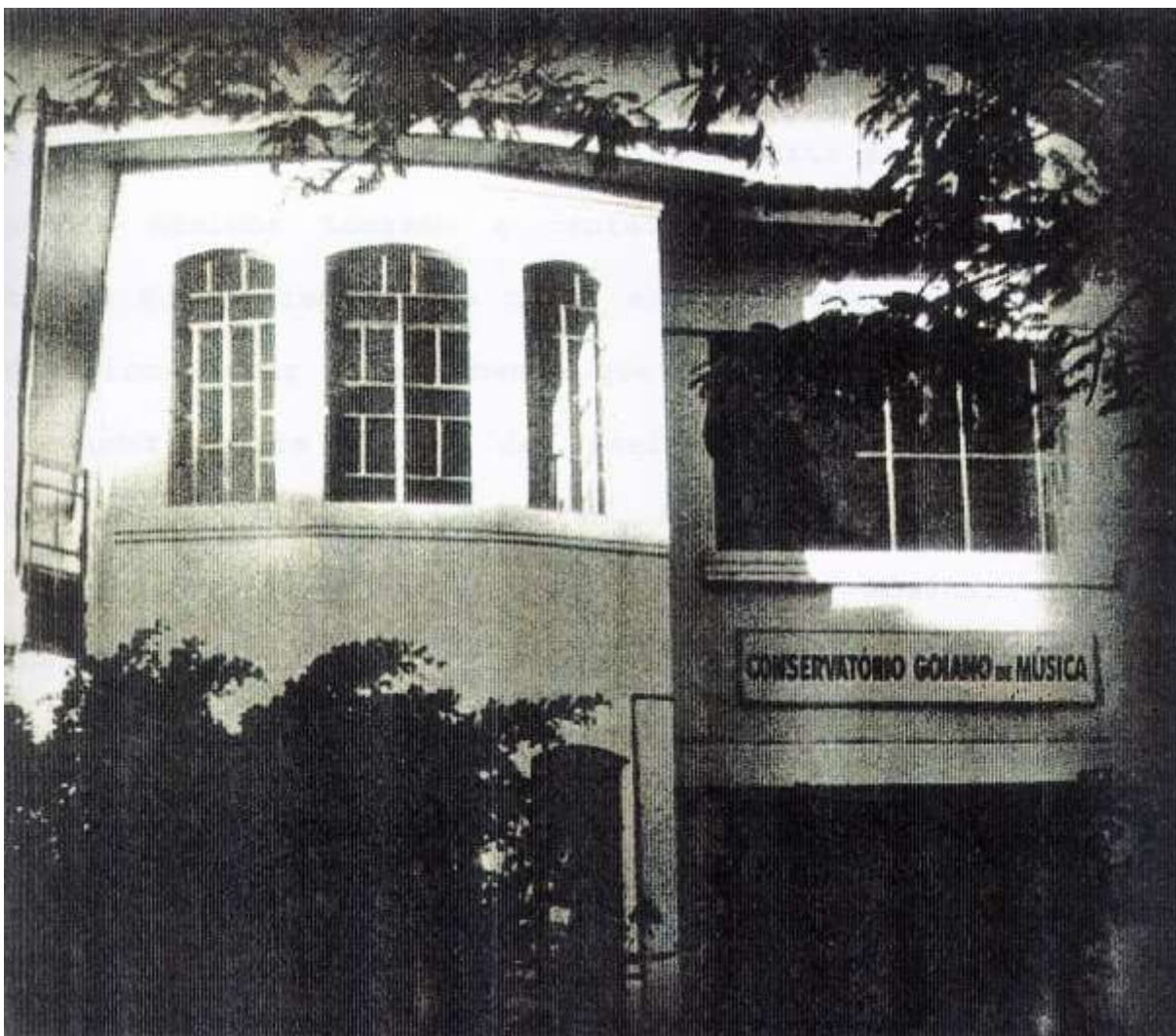
Ilustración 15 – Fachada del Conservatório Goiano de Música , Avenida Tocantins, n. 22, Centro, Goiânia, Goiás
