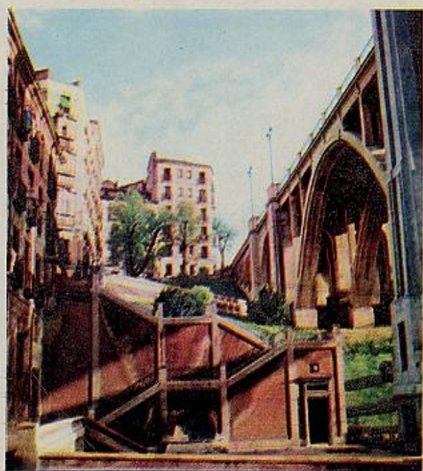
EL VIADUCTO SALTA POR ENCIMA DE LA CALLE DE SEGOVIA, CONTINUANDO LA DE BAILLEN. DESDE ARRIBA SE OBSERVA UNA DE LAS MAS BELLAS PANORAMICAS.
