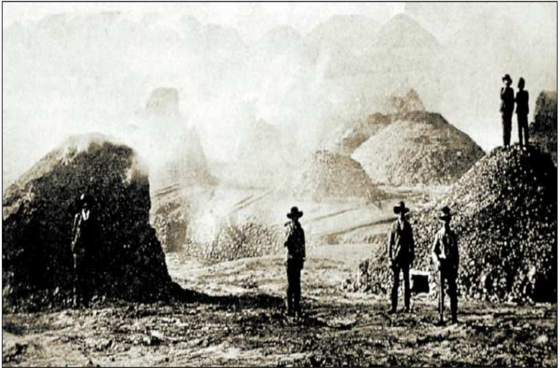
Imagen de las piras de calcinación del mineral al aire libre en Riotinto, llamadas popularmente teleros .
