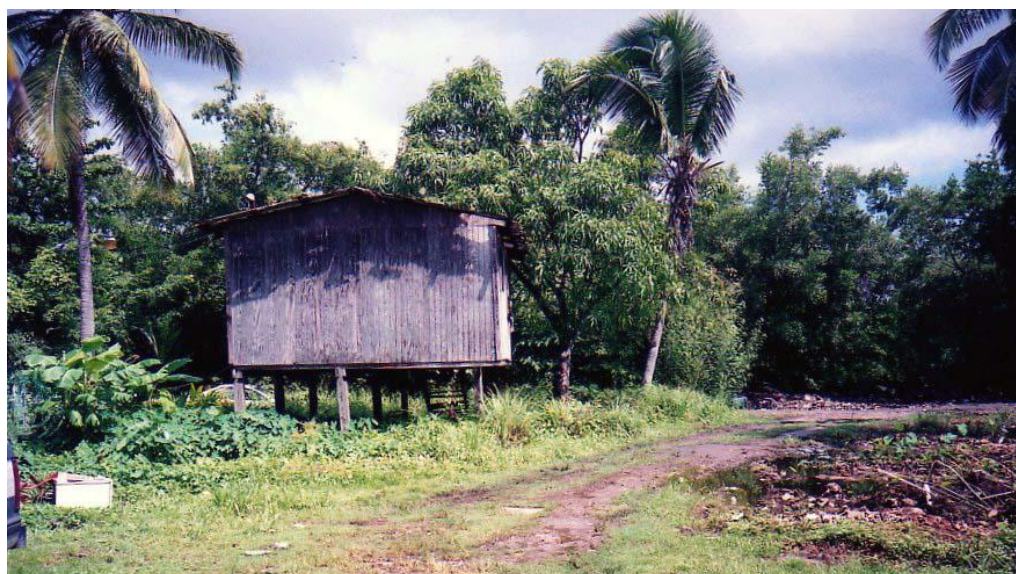
Ilustración 5.8. Vivienda de madera ubicada en zona inundable del caño. Foto de la autora.
