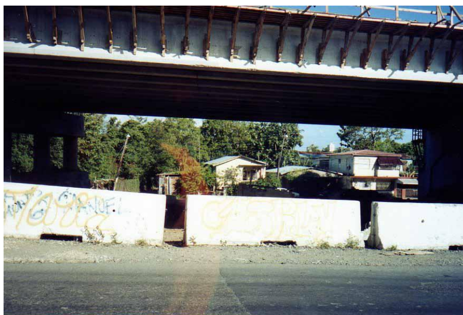
Ilustración 6.6. Puente en construcción sobre el caño. Foto de la autora.
