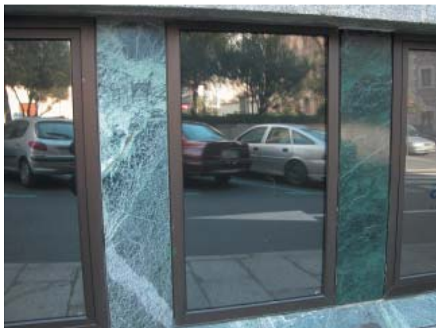
Fig. 4.- La evolución de las serpentinitas, una vez emplazadas en el edificio, puede ser diferente según su composición química y mineralógica. Esto puede dar lugar a coloraciones inesperadas que hacen contrastar de manera notable las diferentes piezas del recubrimiento.
