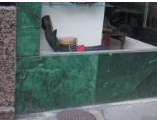
Fig. 5.- b) Nótese cómo el reemplazamiento de la placa da lugar a una modificación notable en las características visuales del conjunto, a pesar del tratamiento de pulido posterior.
