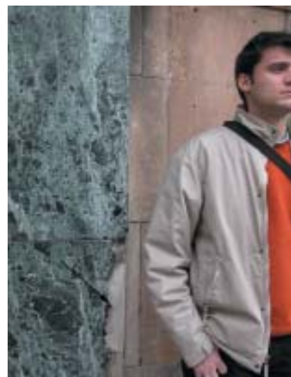
Fig. 3.- El sistema de grietas rellenas de calcita evoluciona en su deterioro, hasta que se produce la ruptura de la placa.
