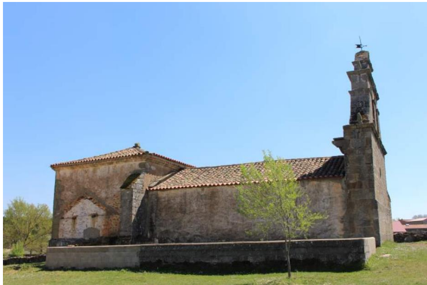
Figura 21 Fachada norte de la capilla, la nave y la espadaña. Fuente: Elaboración propia.
