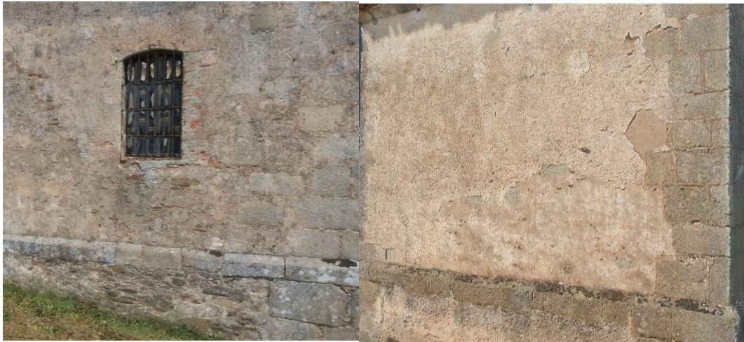
Figura 27 Muro de mampostería y sillares de granito. Fuente: Elaboración propia.
