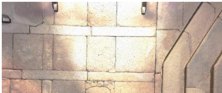
Figura 26 Pavimento de suelo con piedras de granito en forma de red. Fuente: Elaboración propia.
