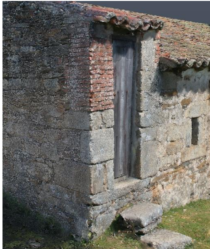
Figura 28 Reparación de muro por ladrillo de macizo. Fuente: Elaboración propia.
