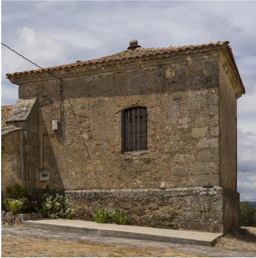
Figura 20 Fachada sur, que tiene la ventana, y la facha este de la capilla. Fuente: Elaboración propia.
