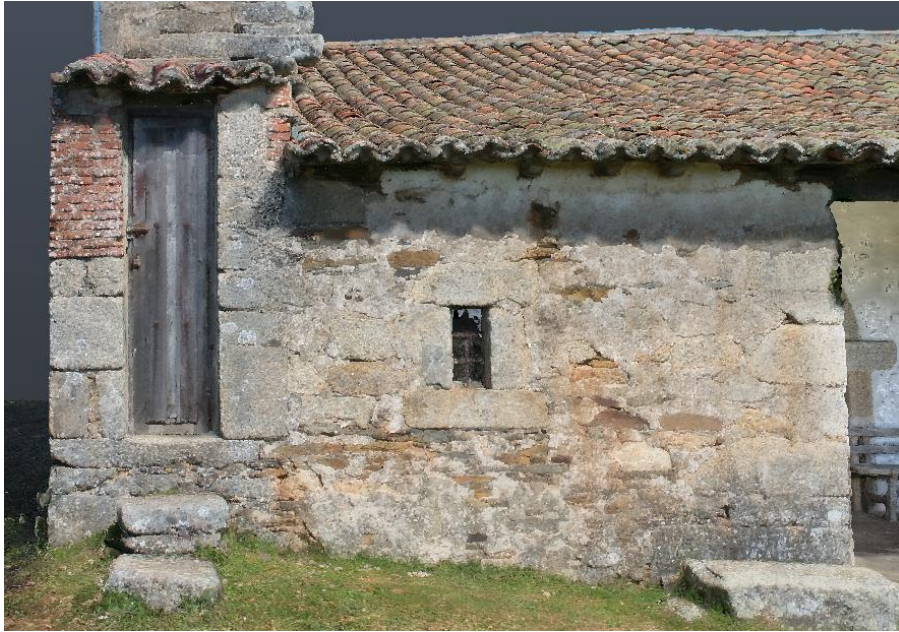
Figura 18 Entrada hacia el campanario y la pequeña ventana de sacristía de la izquierda. Fuente: Elaboración propia.
