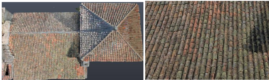
Figura 25 Tejado de la iglesia Ceadea, vista desde arriba. Fuente: Elaboración propia.
