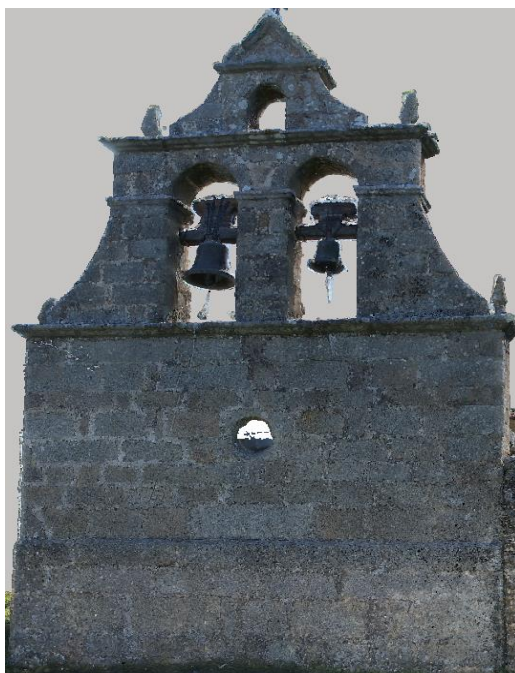
Figura 29 Muro de sillares de granito de la espadaña. Fuente: Elaboración propia.
