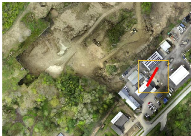
Figura 62: Localización de los cables
