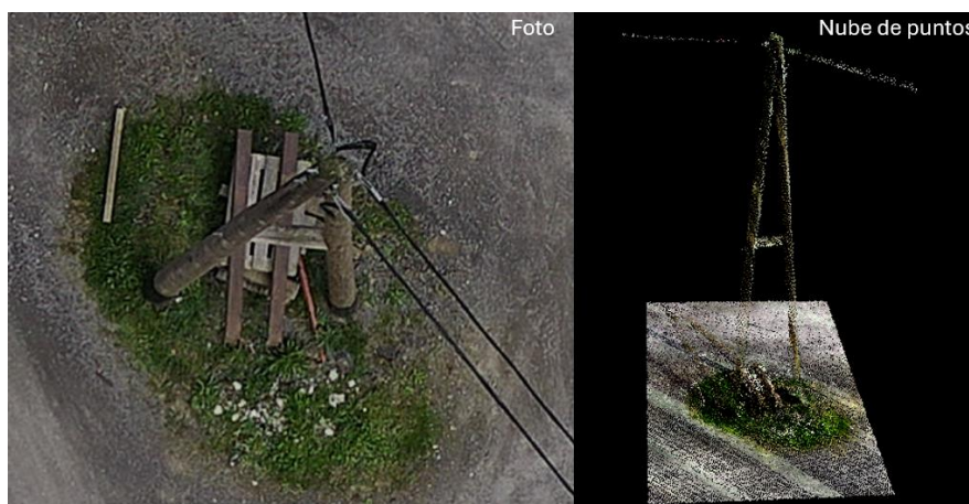
Figura 60: Vista del poste TV540 60m 6ms
