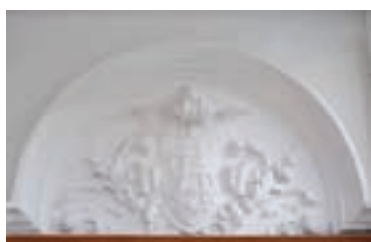
Fig. 17 Relieve sobre la puerta que comunica el vestíbulo con el hall de la casa de Ramón de la Sota, paseo de Zugazarte, Getxo. Arquitectos Frederick Chatterton y William Edward Couch
