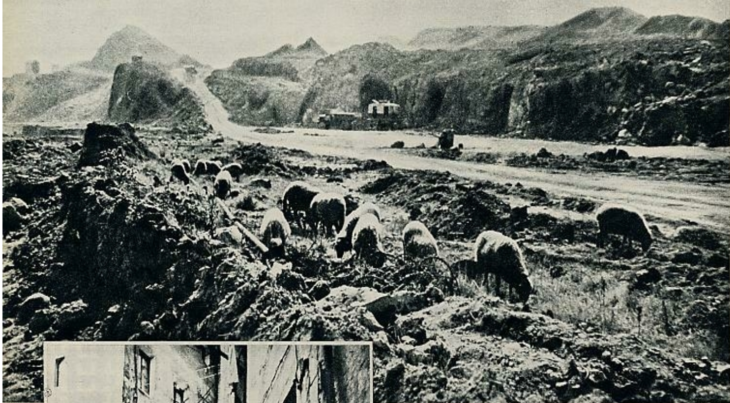
Los corderos pastan tranquilos entre viejas vías, buscando la yerba nacida sobre las tierras removidas de la mina. Se encuentra ésta en lo alto de un cerro, y desde allí se domina el Bilbao viejo, que empieza en la misma loma.
