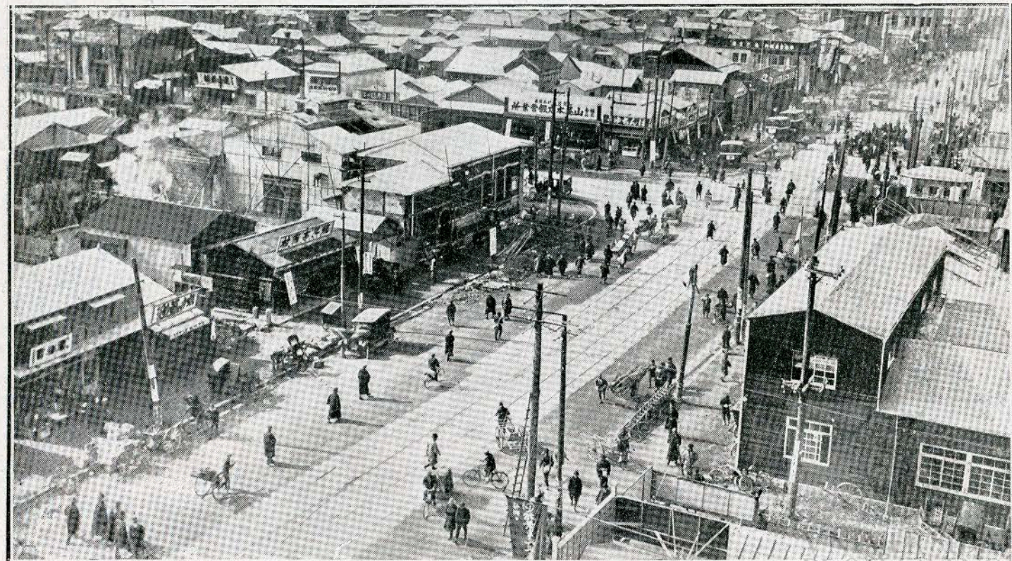
LA RECONSTRUCCIÓN DE TOKIO. —Aspecto que presenta en la actualidad la calle principal y uno de los barrios más populosos, completamente destruidos por el terremoto de Septiembre de 1923
