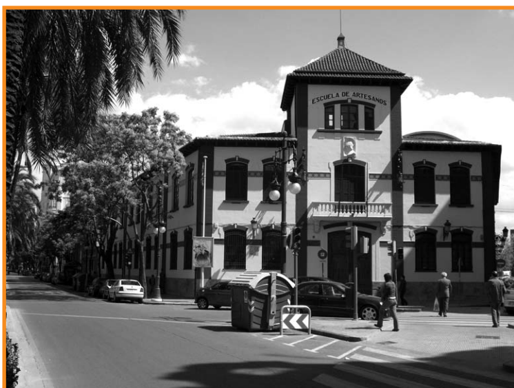
Escuela de Artesanos en Valencia, en una imagen de 2007. En este edificio estuvo la sede de la Biblioteca-Escuela
