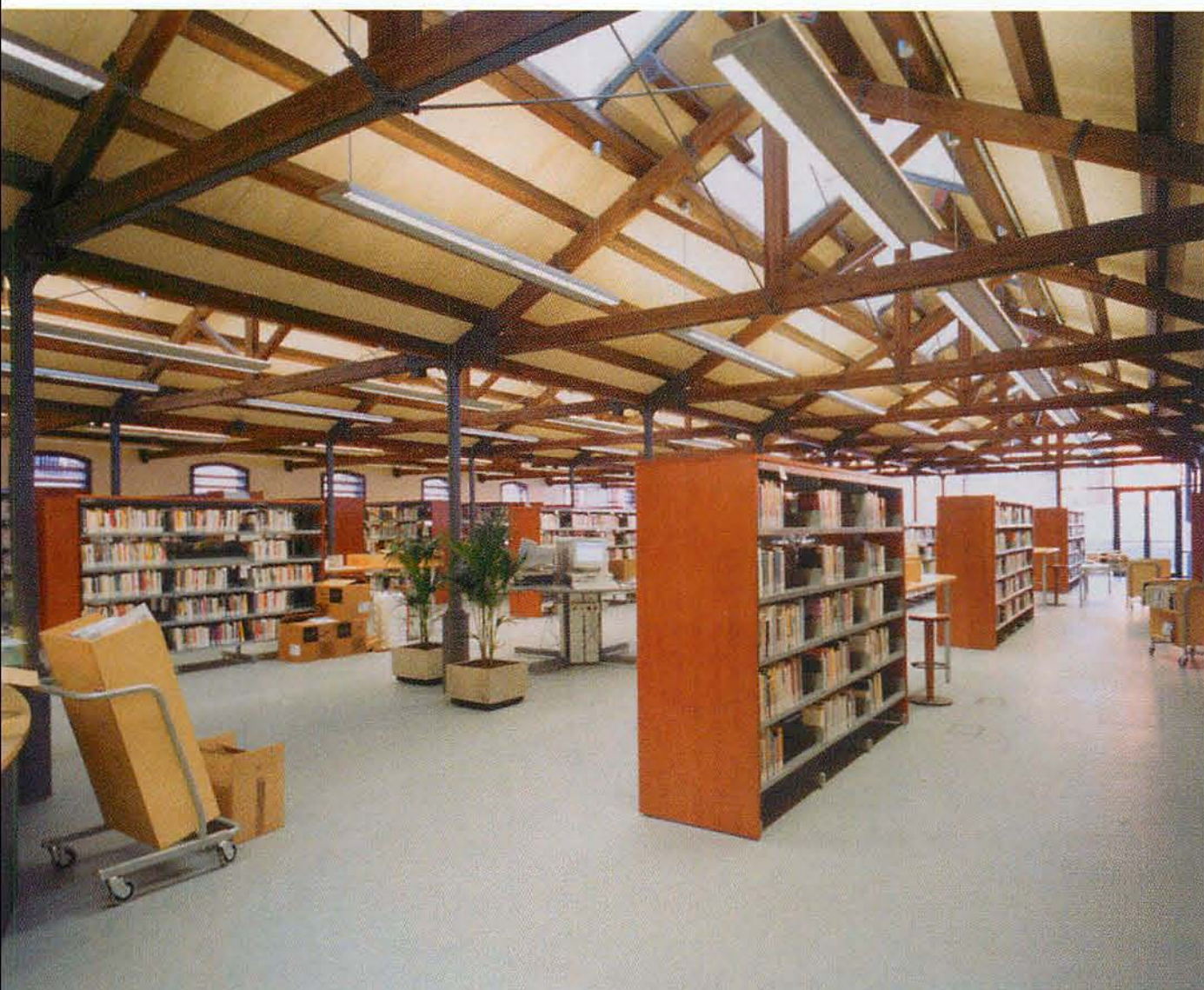
Vista global de la Biblioteca Vapor Badia de Sabadell (Barcelona). Foto cedida por la Diputación de Barcelona
