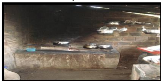
Foto nº 46 – Assentamento Hipólito. Falta de conhecimento e falta de práticas na higiene..
