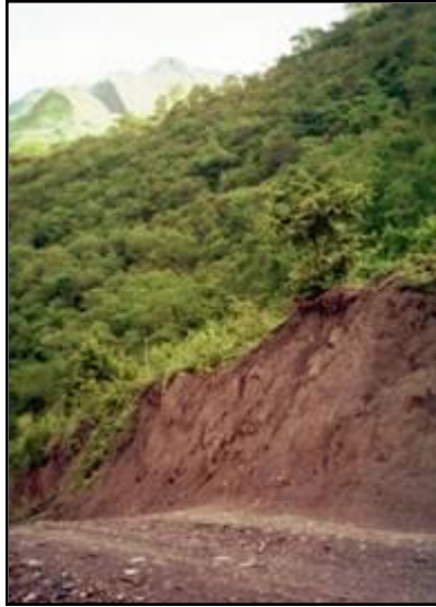
Foto No. 2.7 Coluvio reciente en la zona de piedemonte de Liberia, en la margen derecha aguas arriba del río Patá.
