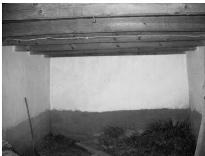
En el "sobrao" o "doble", que se encontraba en el primer piso se guardan enseres domésticos y agrícolas como el heno.
