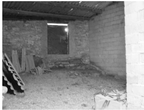
Detalle de dos buracanes realizados en momentos cronológicos diferentes
