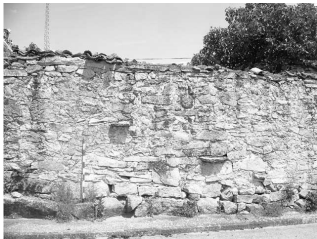
Pared exterior con restos de revoque de una casa tradicional.
