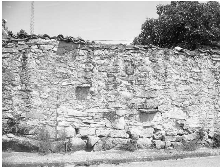
Pared exterior con restos de revoque de una casa tradicional.
