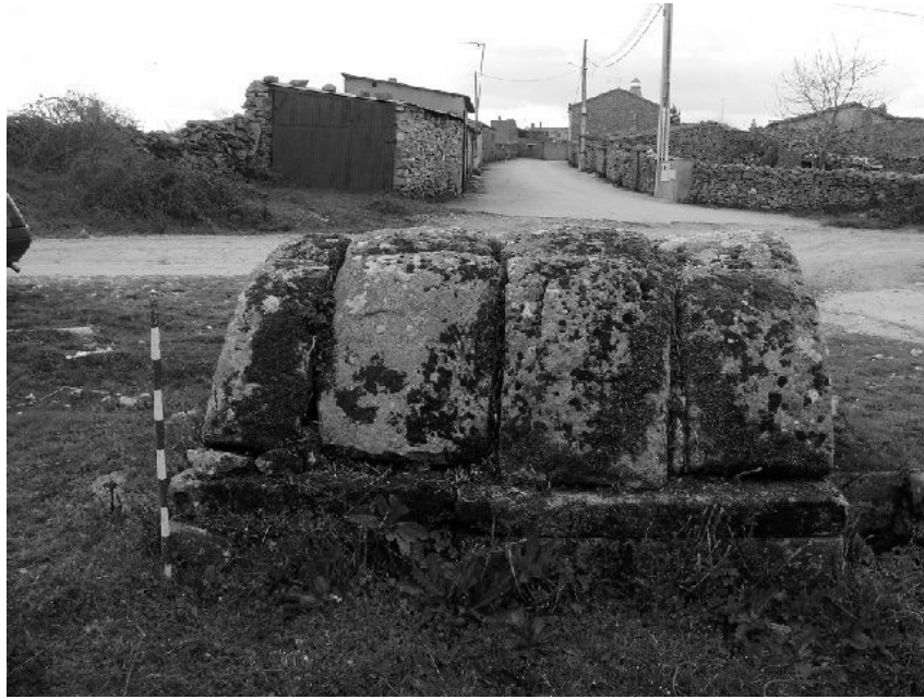
Las dovelas sin mortero son elementos característicos en estas estructuras.
