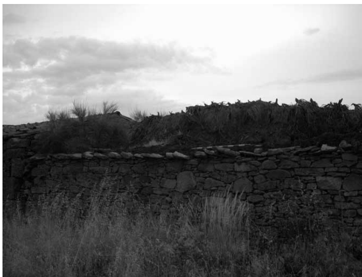
Poco después de realizarse las fotos su techado fue destruido.
