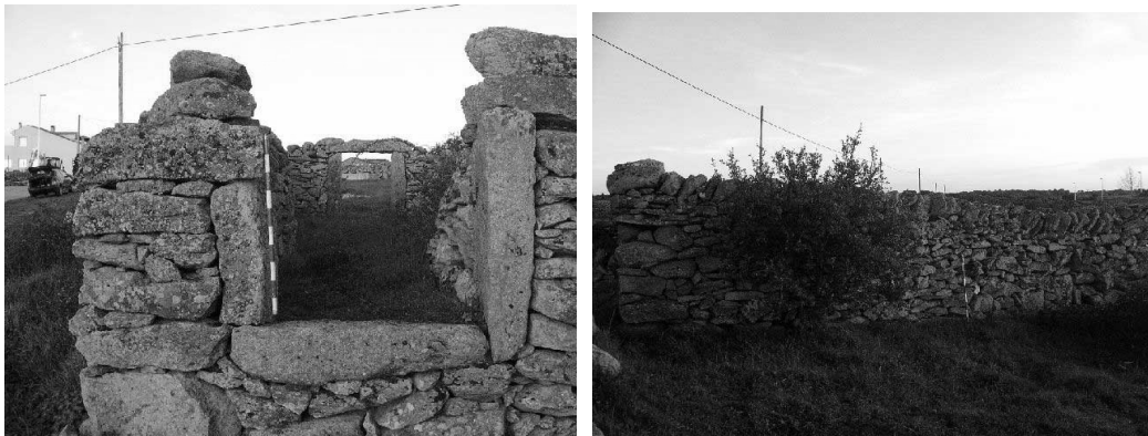
Una de las últimas construcciones productivas realizadas de forma tradicional.
