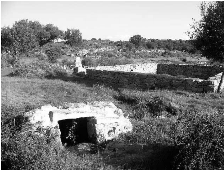
Conjunto de fuente chica, en primer plano y lavadero al fondo.
