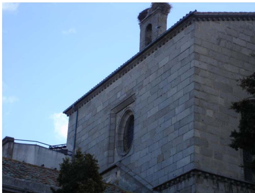
5.63. Restos arquitectónicos en el muro occidental de la cabecera.
