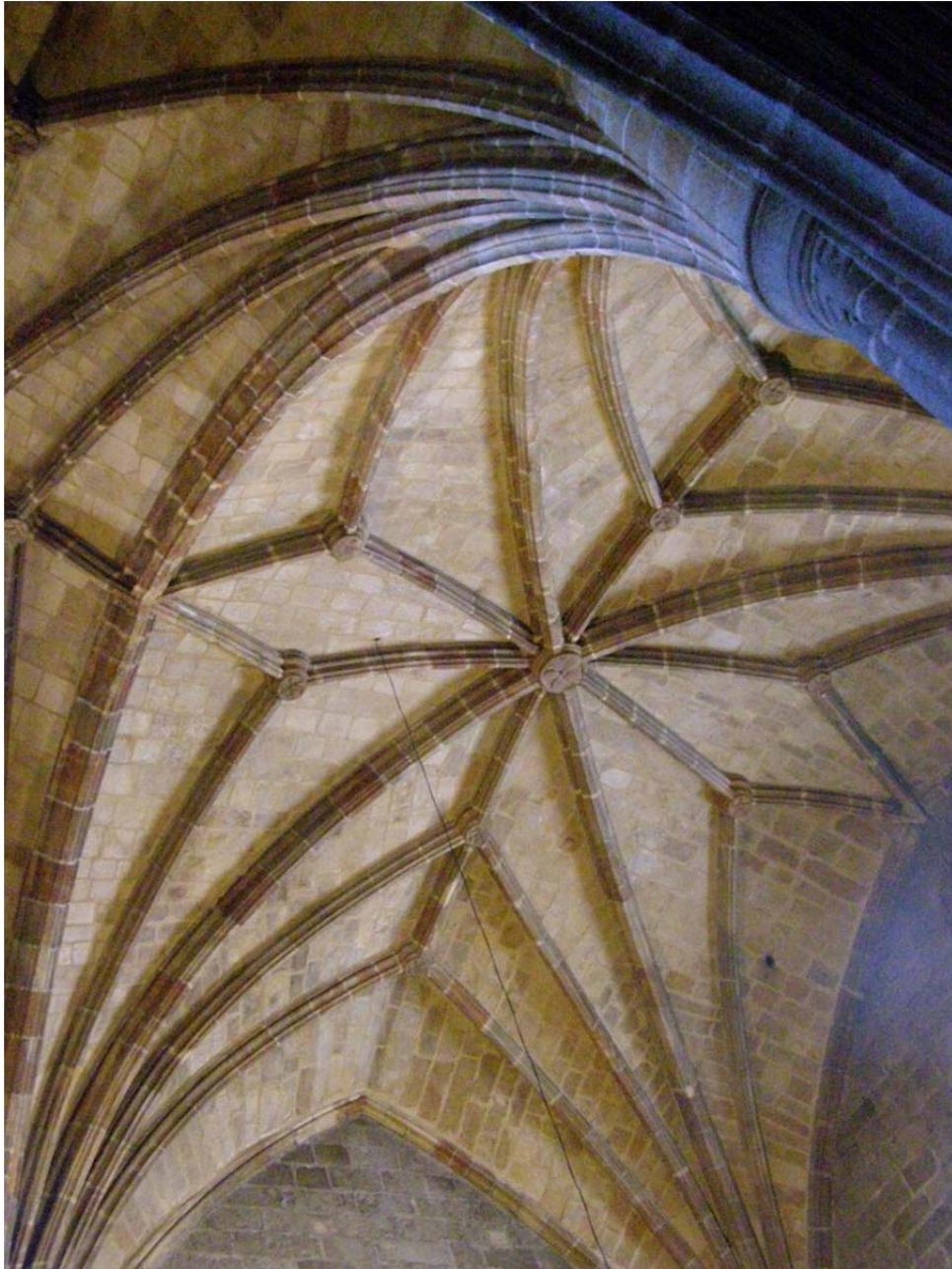
4.27. Bóveda de la iglesia de San Juan
