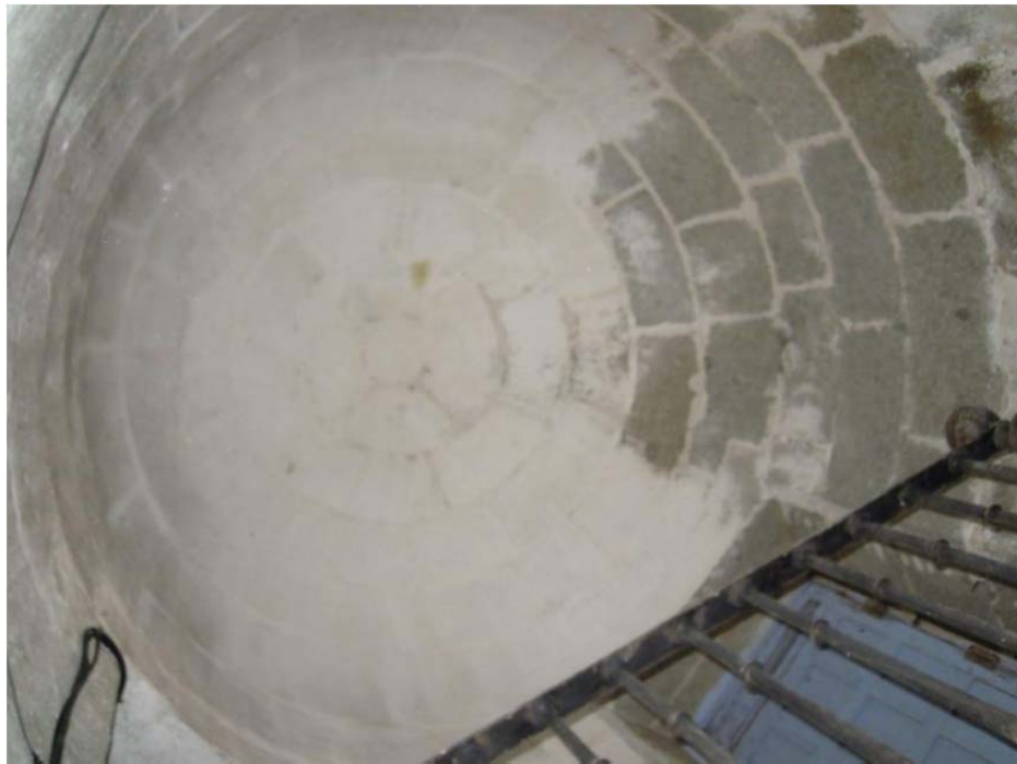
5.47. Cúpula de media naranja del caracol de la torre.
