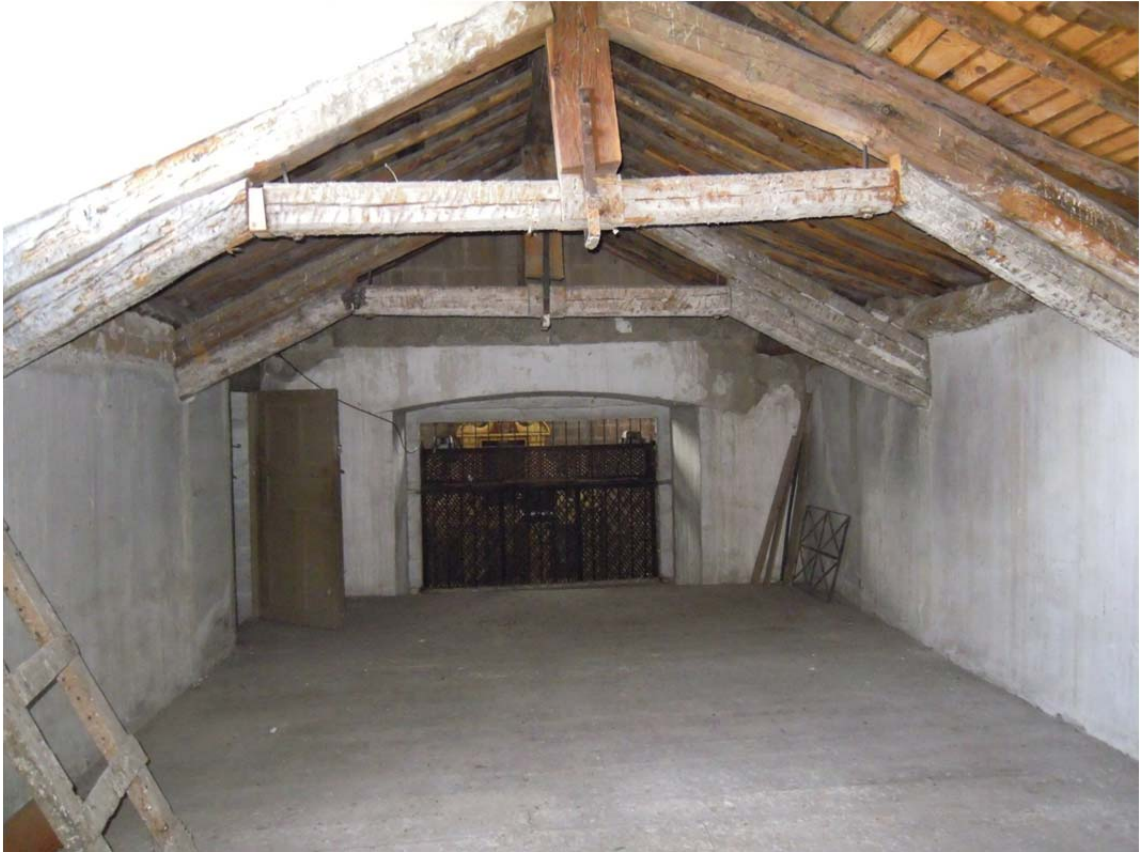
5.84. Dependencia sobre la bóveda plana del vestíbulo
