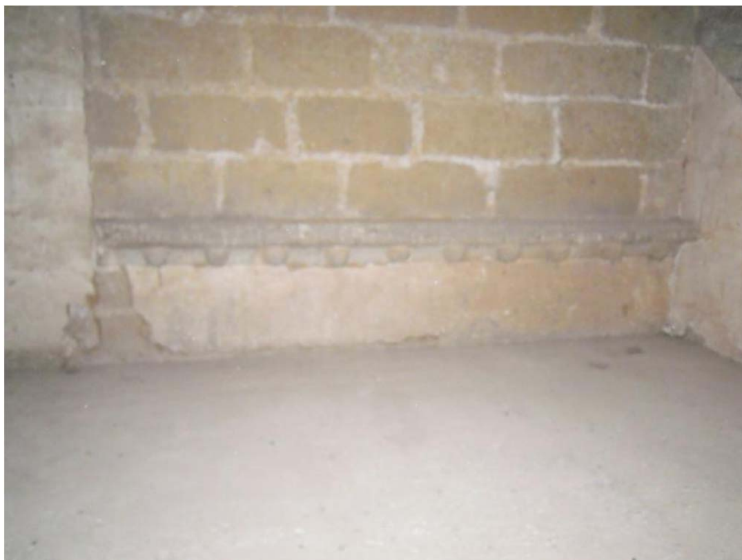
5.64. Restos de la cornisa de bolas en el interior de la torre.
