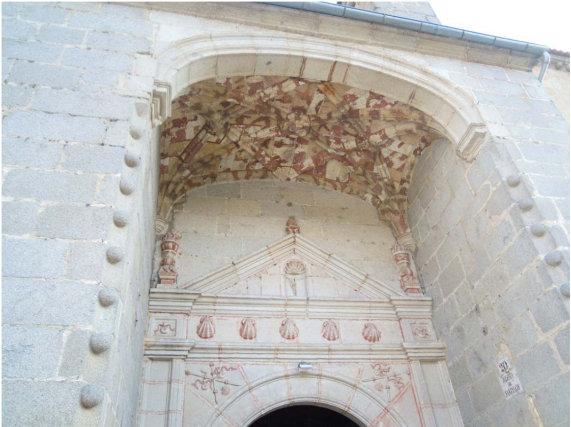
4.77. Pórtico de la iglesia de Santiago Apóstol
