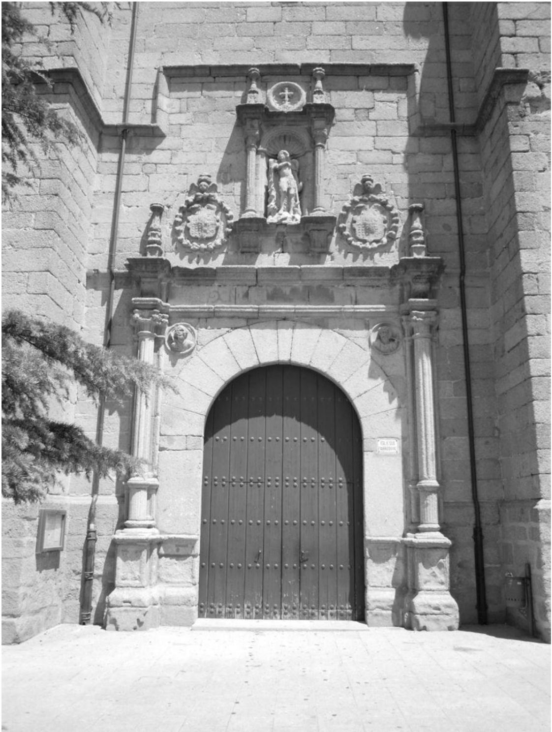
4.25. Fachada meridional de la iglesia de San Miguel Arcángel de Peñaranda de Bracamonte
