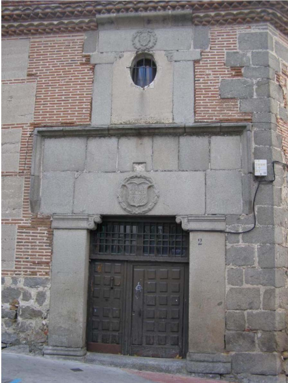
4.1. Ejemplo de la alternancia de sistemas constructivos en la casa de Luis de Guillamas (hoy convento de las Adoratrices)
