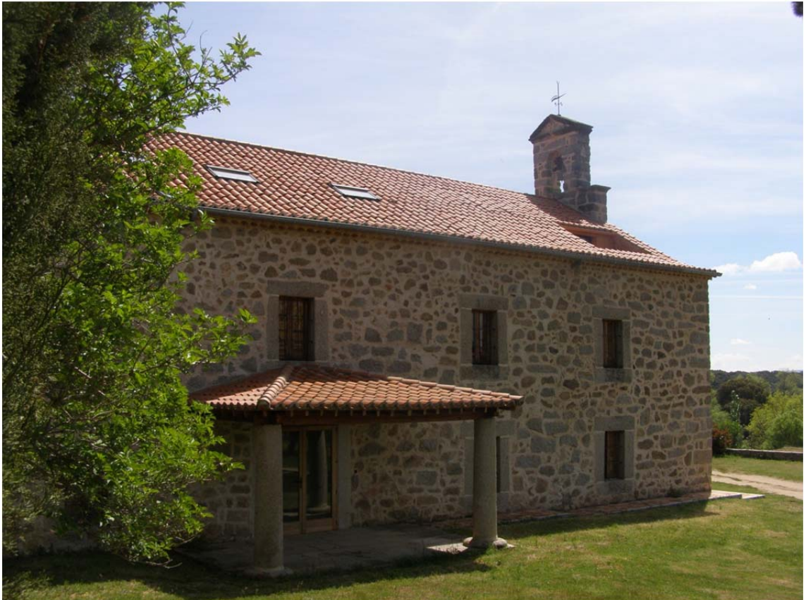
5.135. Antigua iglesia de Los Jesuitas. Hoy vivienda.
