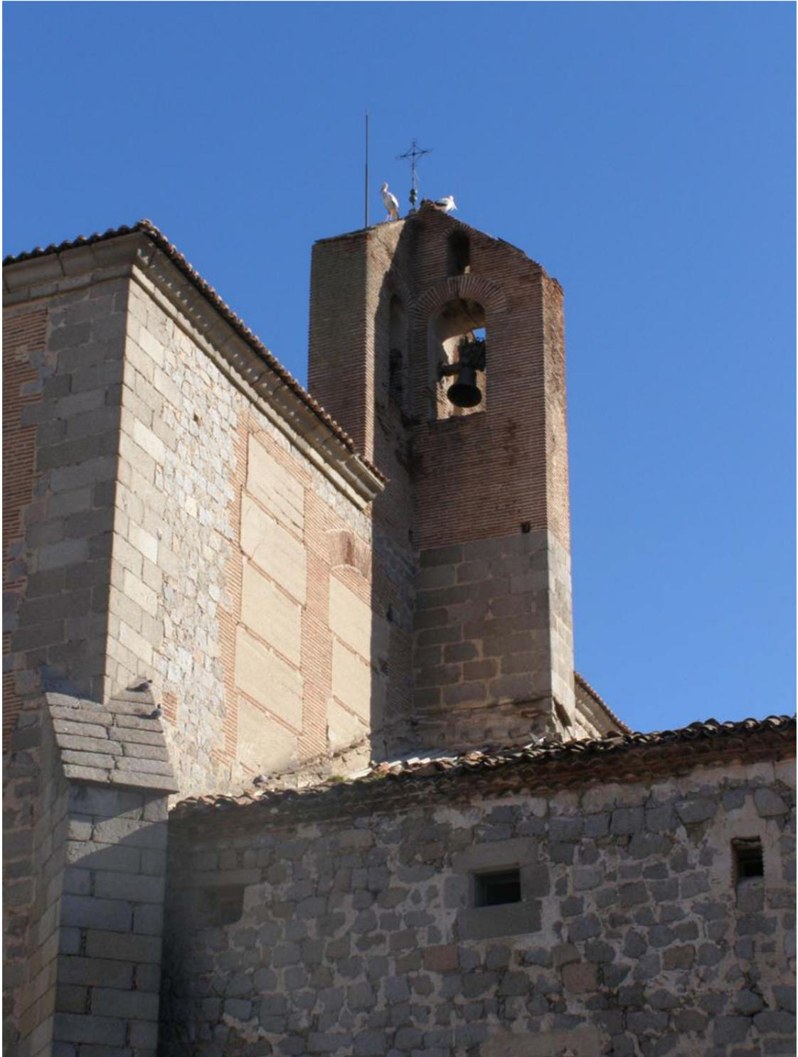
4.2. Diferentes ejemplos de la construcción mural en la arquitectura abulense. Iglesia y convento de Santa María de Jesús, "las Gordillas"
