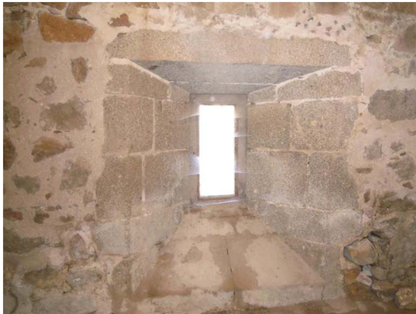
5.16. Ventana abocinada del interior de la sala baja del convento 1079
