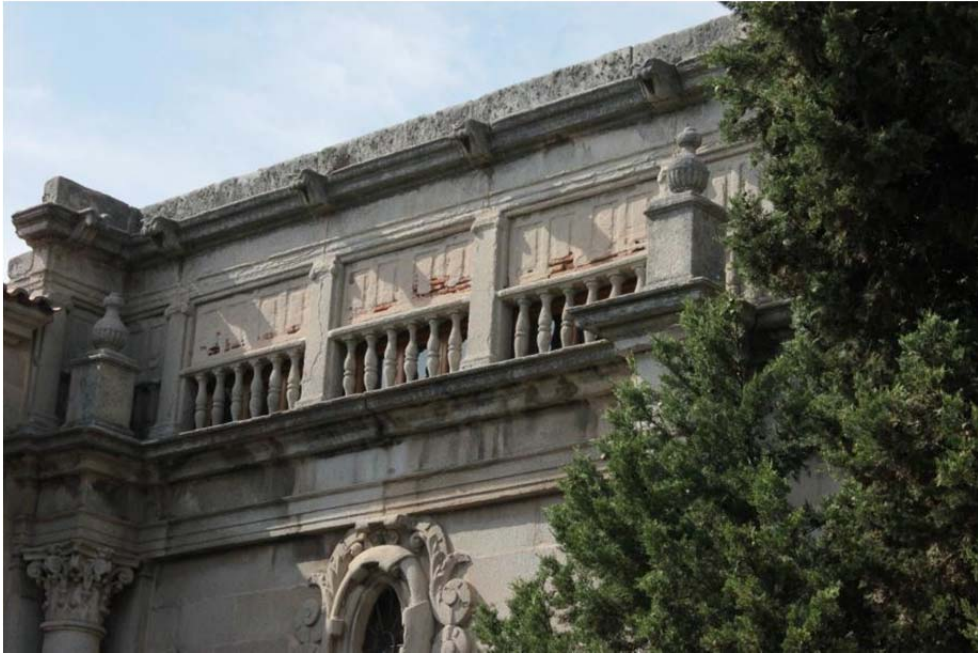
5.38. Detalle de la balaustrada abierta.
