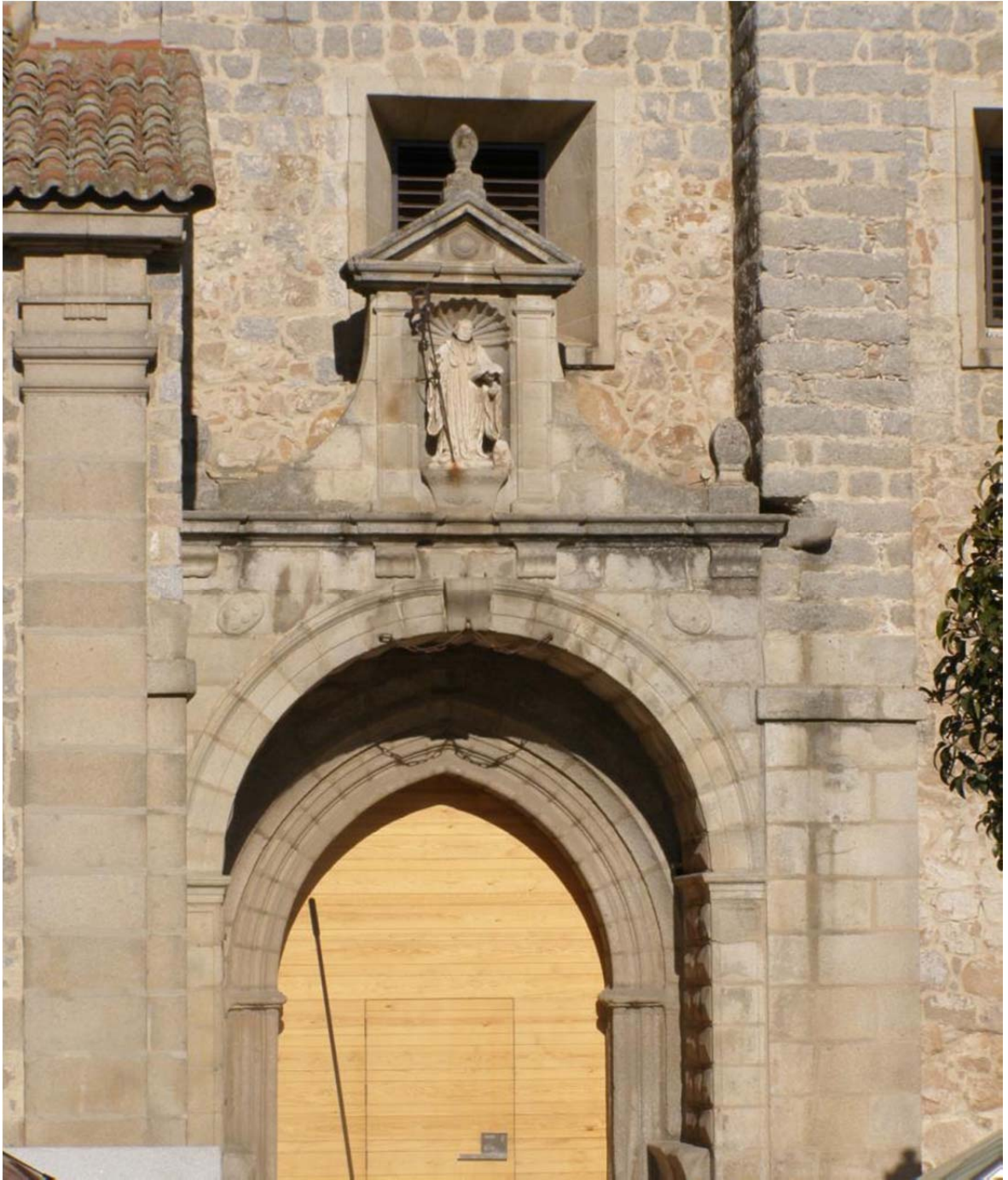
4.22. Puerta de la iglesia de Sta. Ana.
