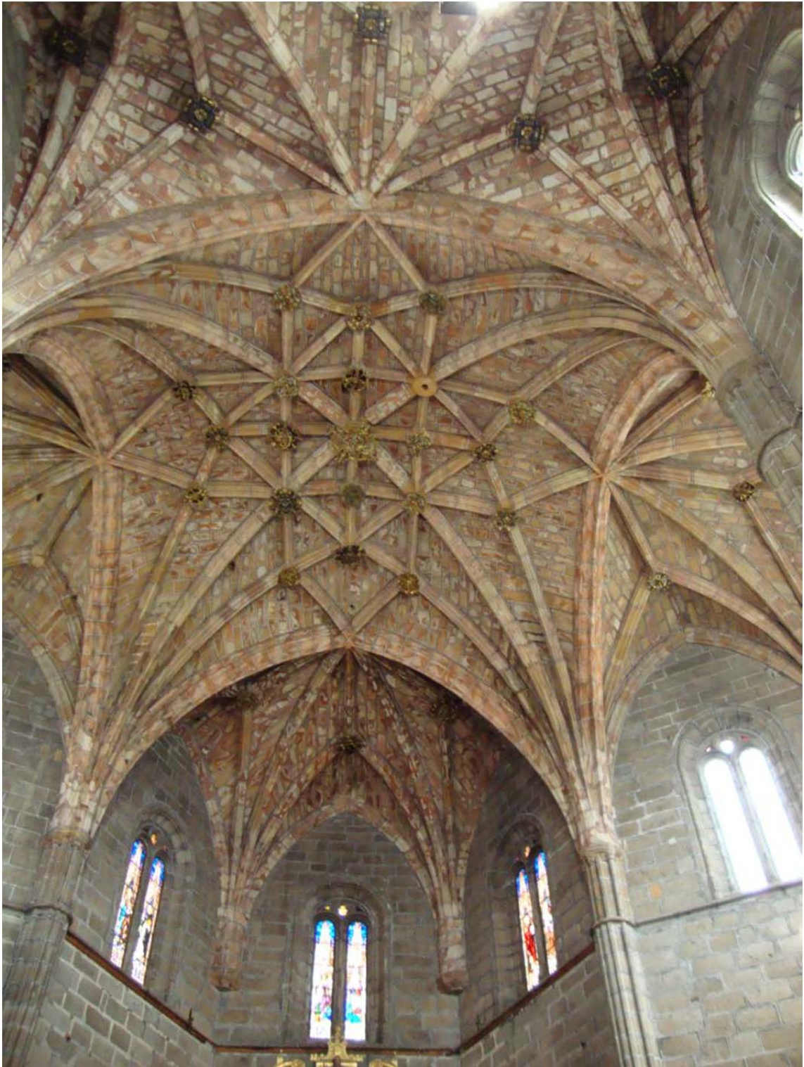
5.29. Bóvedas, ventanas y soportes
