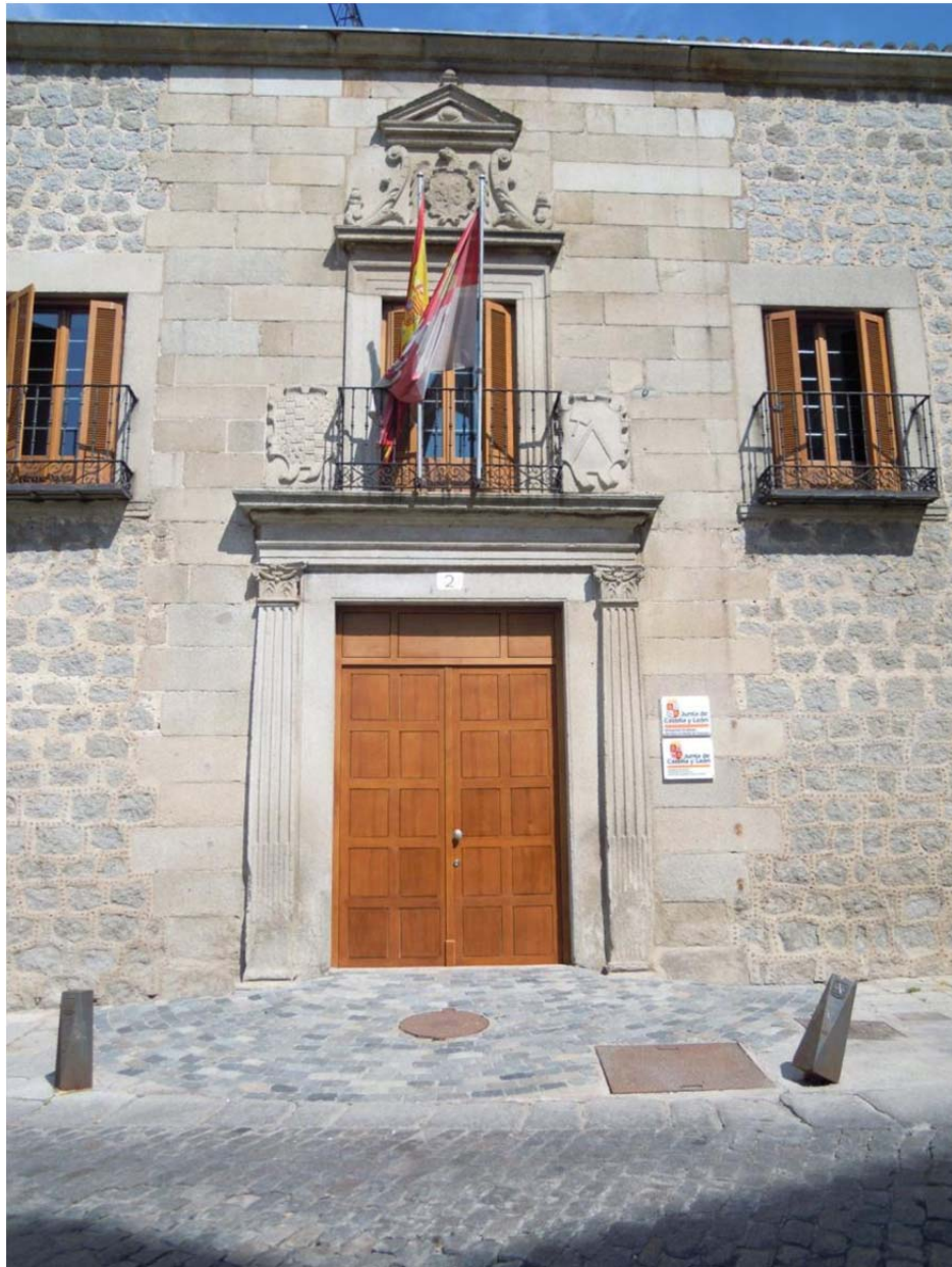
5.120. Casas de Gaspar del Águila y Bracamonte
