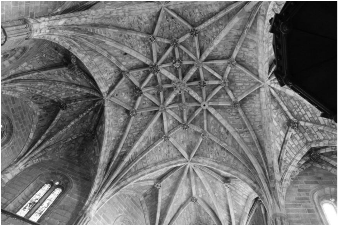
5.66. Bóvedas de la capilla
