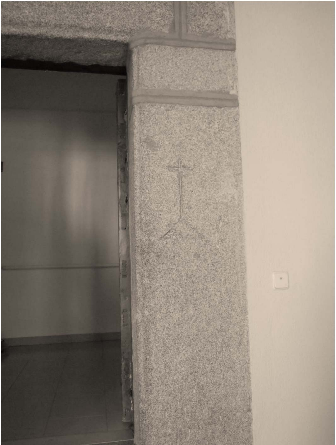
5.94. Detalle de la jamba de una portada.
