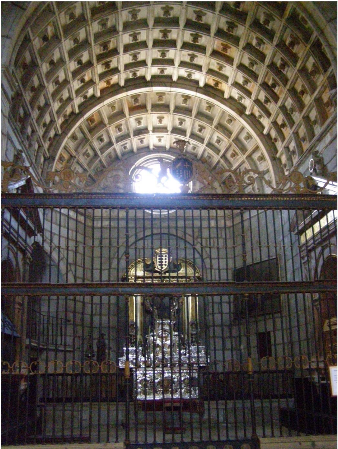
4.34. Bóveda de medio cañón con casetones en la capilla de la Concepción de la catedral
