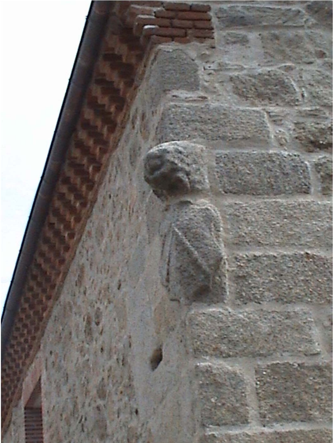
5.129. Escudo de la casa de La Pavona
