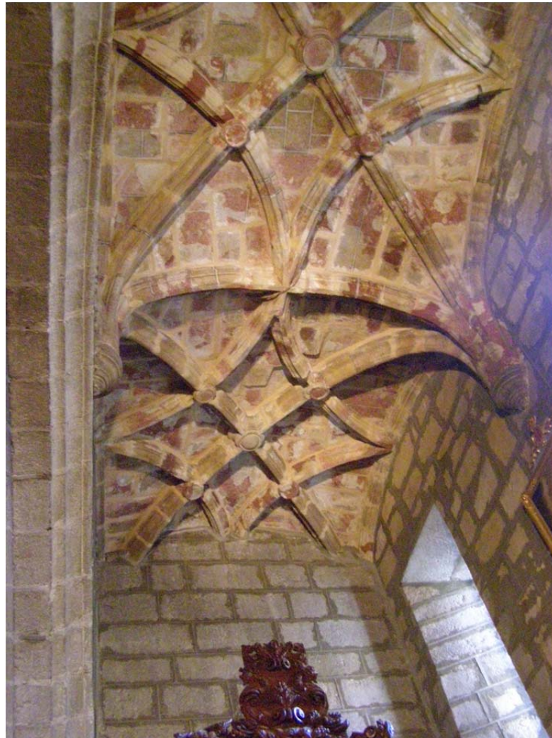
4.33. Bóveda de una capilla lateral de la iglesia de San Juan
