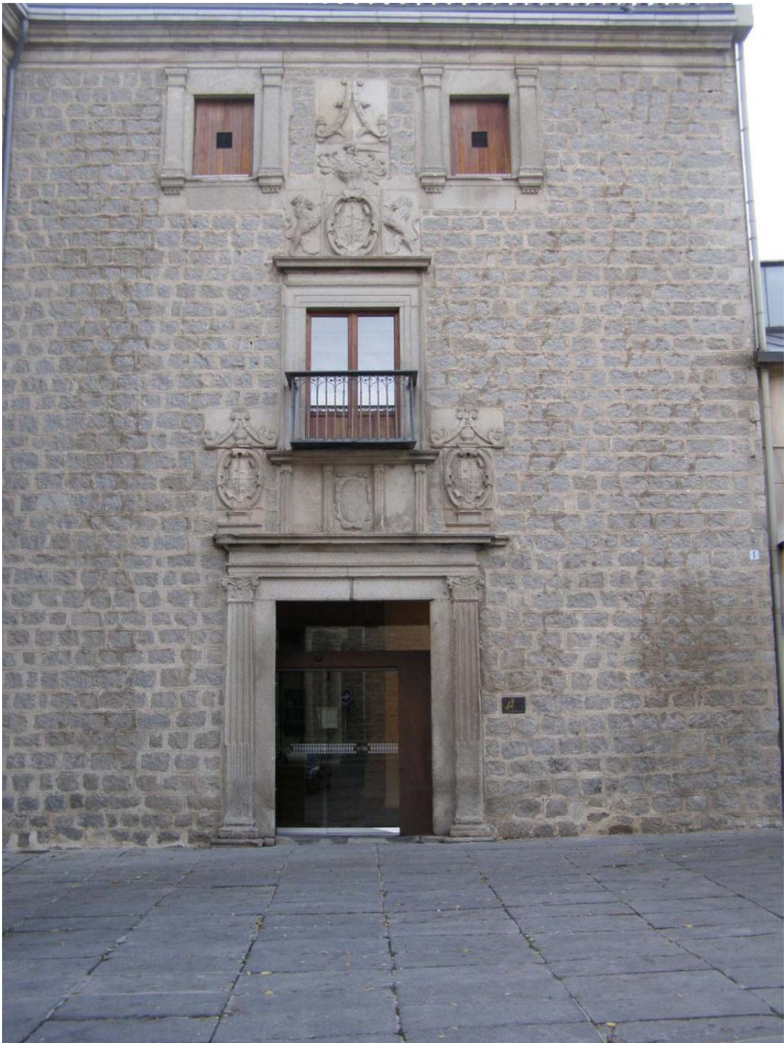
4.20. Fachada de la casa de Per Álvarez Serrano
