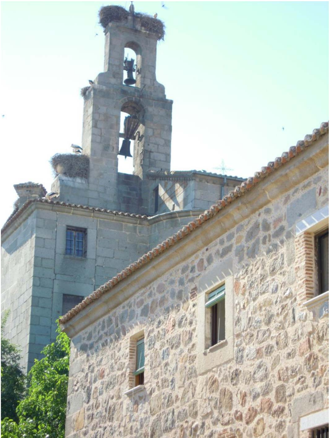
5.88. Fachada norte del hospital y espadaña de la capilla.
