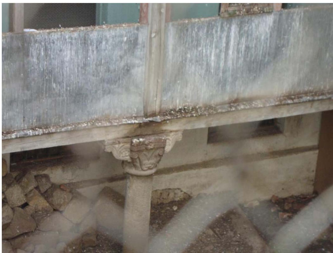
5.60. Restos del patio de la casa del mayordomo 1196
