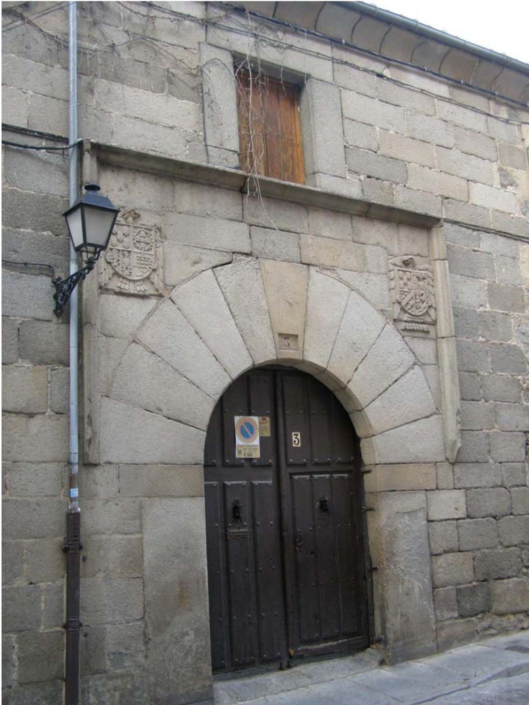
4.58. Casa de Lesquinas.
