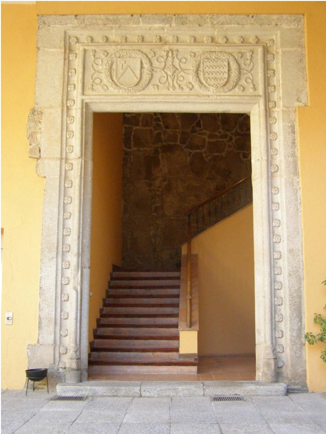
5.117. Puerta del patio
