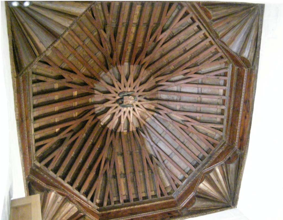
4.29. Cubierta ochavada de la escalera de la casa de Suero del Águila. Atribuida a Rodrigo de Matienzo. 1525
