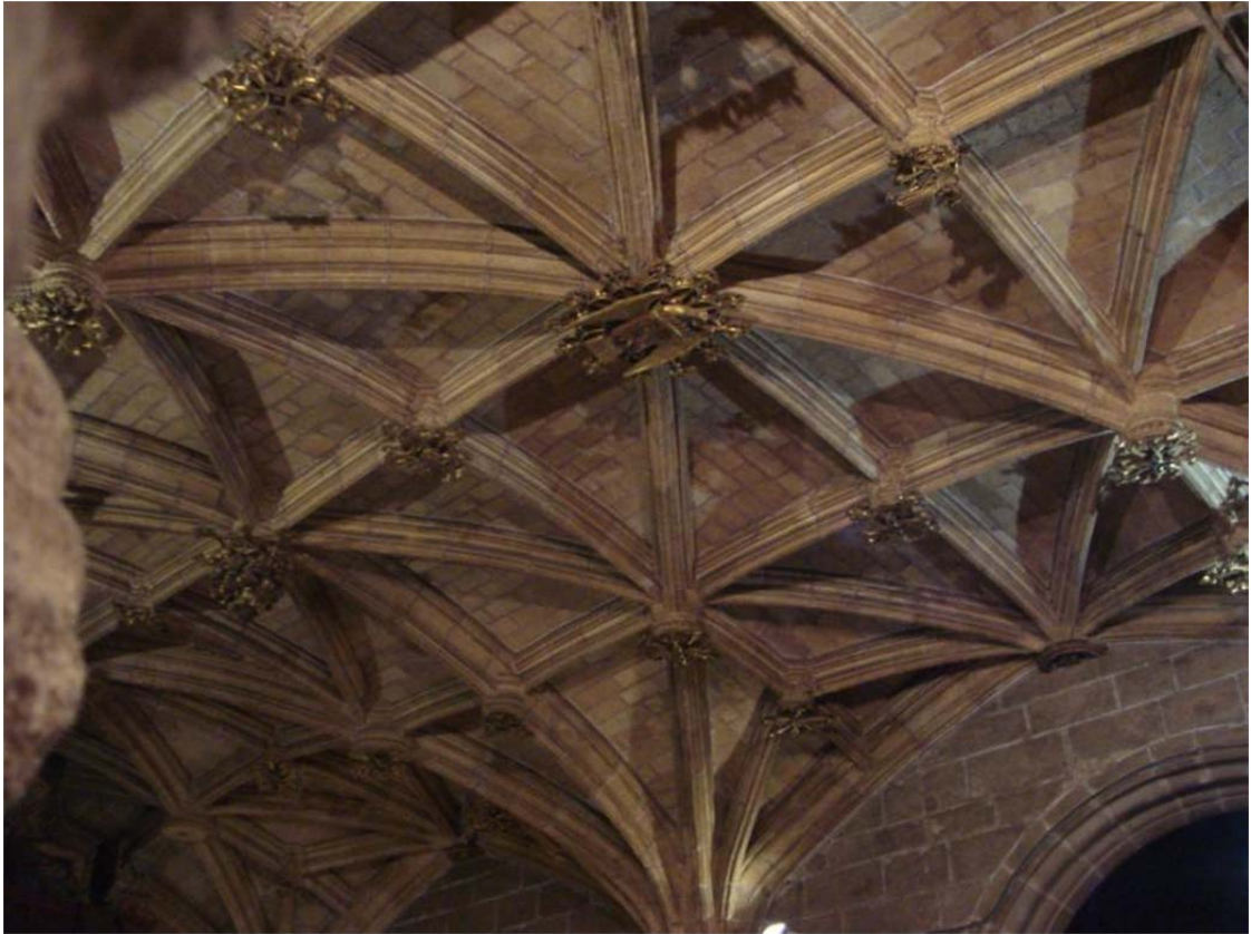
4.10. Bóveda de la iglesia de Santo Tomás
