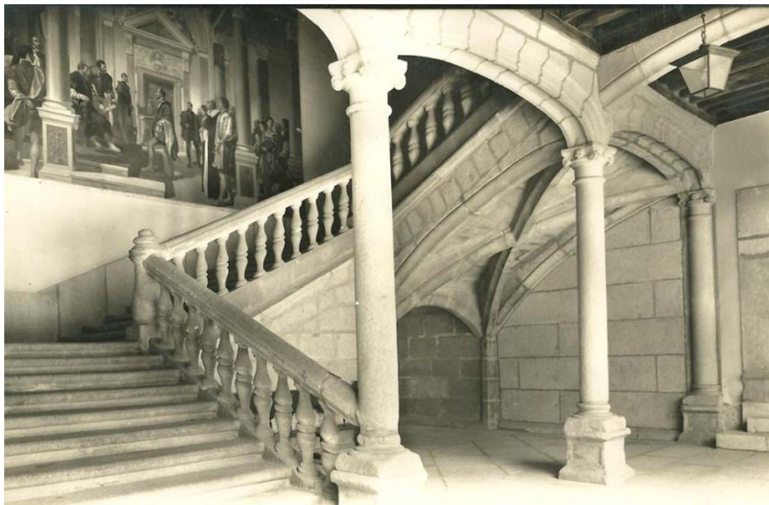
4.86. Escalera de la casa de Blasco Núñez Vela.
