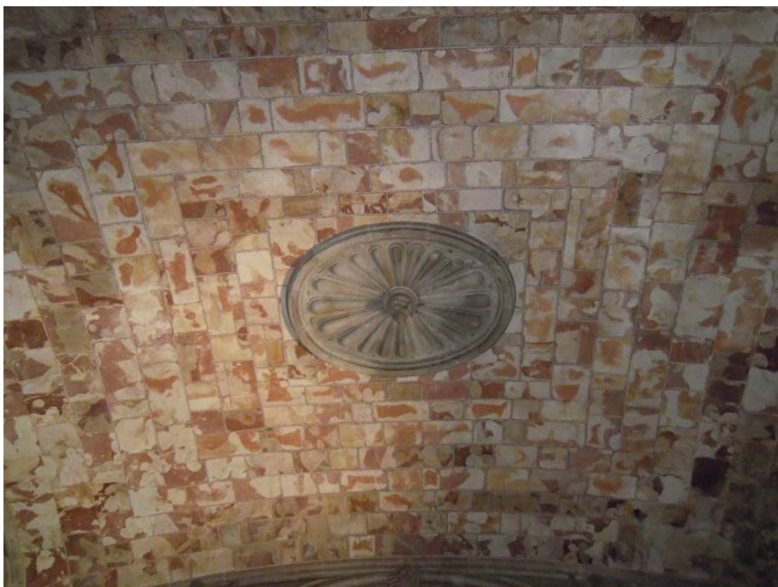
5.34. Bóveda plana del zaguán
