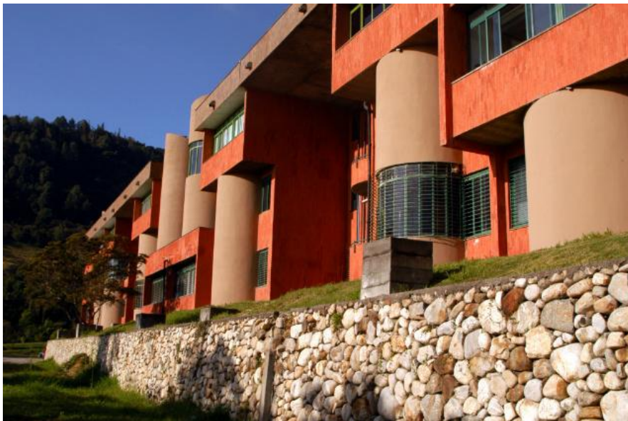
Figura III-12. Vista de la Facultad de Arquitectura. Conjunto Hechicera. Zona Norte (foto propiedad de la Dirección de Imagen Institucional de la ULA y cedidas en septiembre de 2008).
