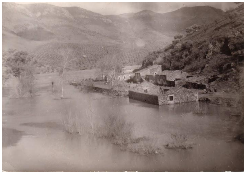
Fotografia de uma inundação do Muelle de Vega de Terrón (década de 1960)
