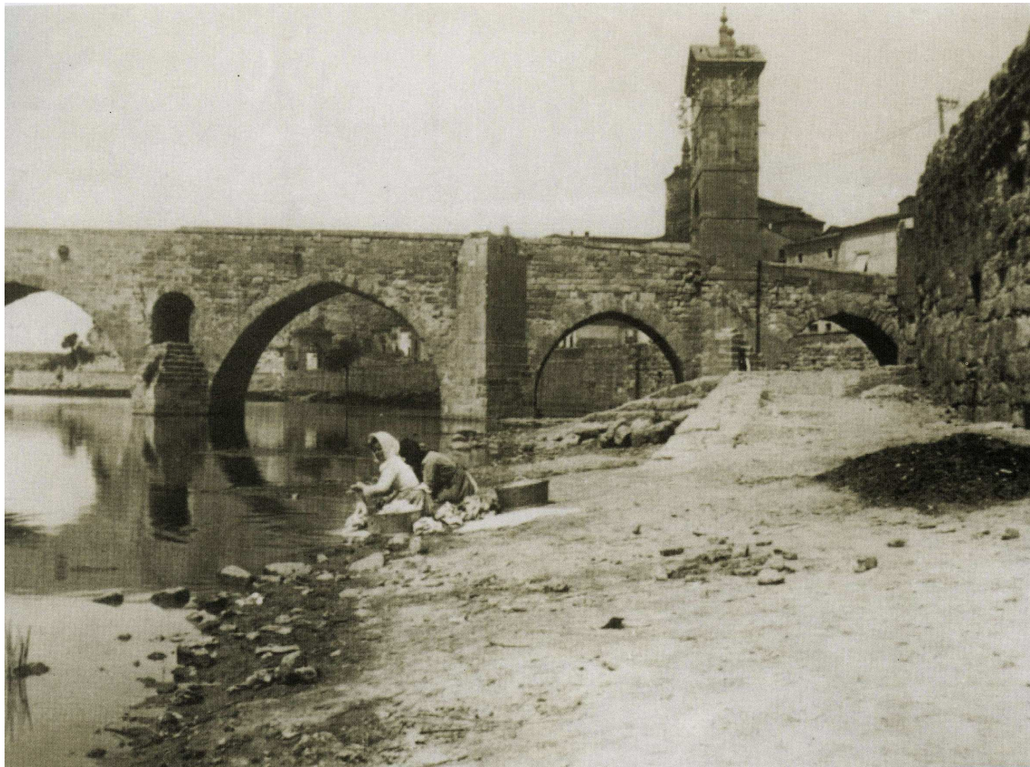
11: Arco de entrada. Vista desde aguas arriba, con puerta de las Ollas en primer plano.
