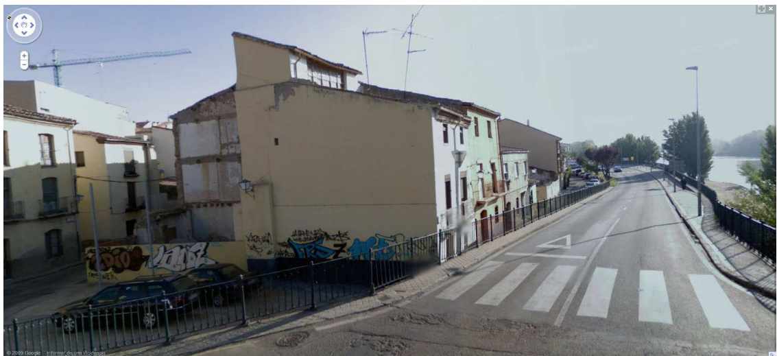
33, 34 y 35: Rampas de acceso al puente desde su extremo norte. Estado actual.
