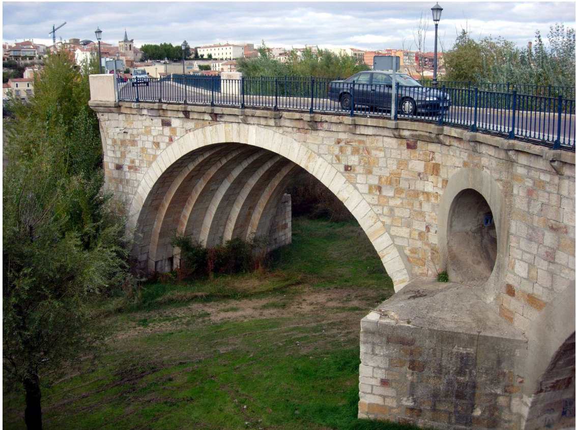
27: Vista del Arco 2 reconstruido.
