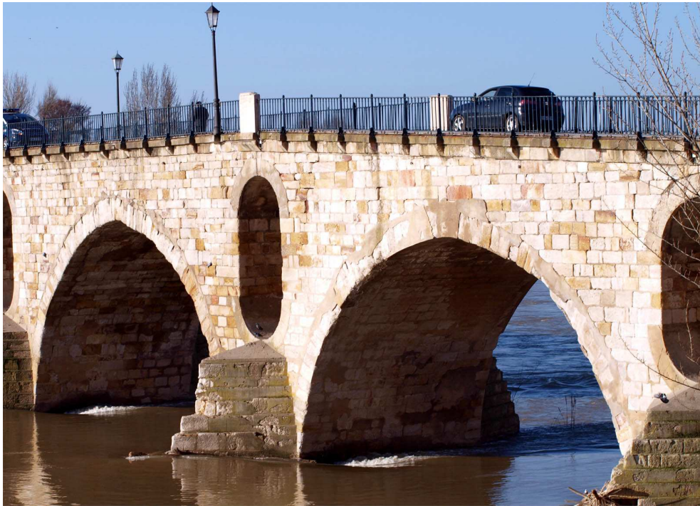
20: Vista de los muretes previstos en los cambios de rasante del tablero (extremo norte del puente).
