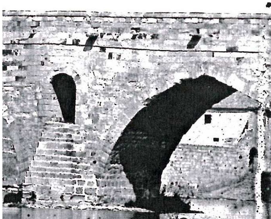
31: Puente sobre el Duero en Zamora (J. Laurent). Detalle del arco 8 desde aguas abajo.
