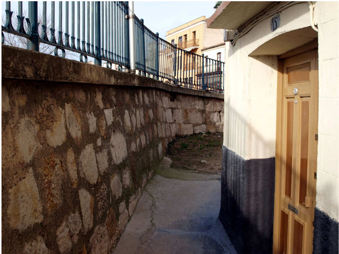
25: Rampas de acceso al puente. Estado actual.
