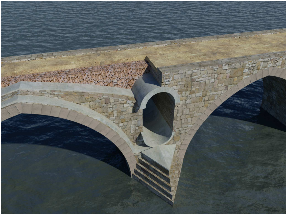
17 y 18: Alzado y perspectiva explicativos de la reforma proyectada y ejecutada por Luis de Justo para el puente de piedra sobre el río en Zamora (1905-1907).
