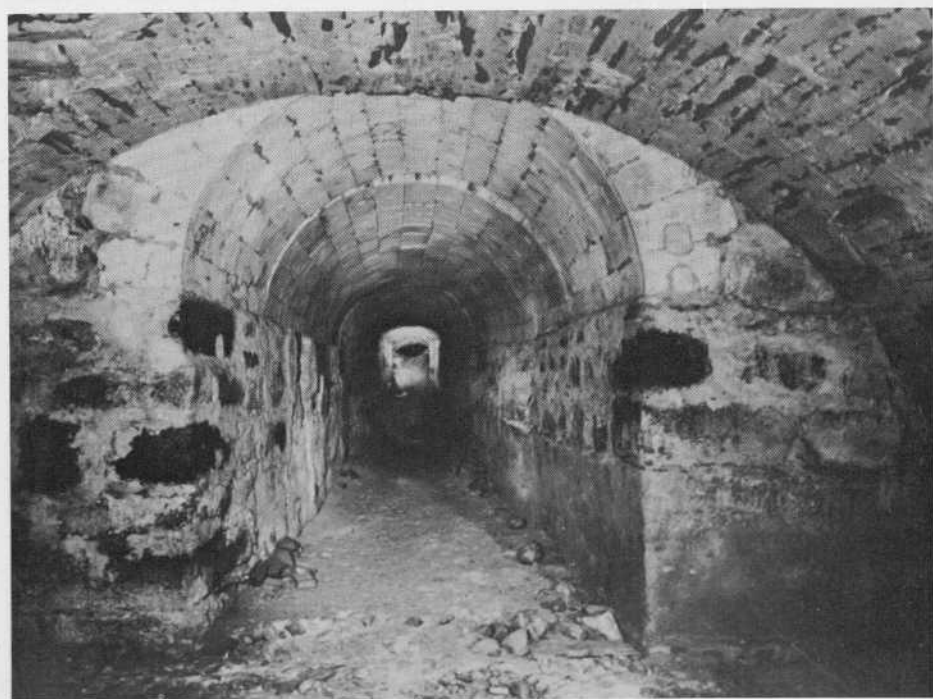
Cuerpo secundario de la galería y depósito subterráneos de agua en la Universidad Pontificia
