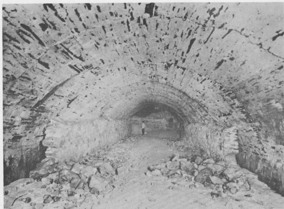
Cuerpo principal de la galería de captación y depósito subterráneos de agua, en la Universidad Pontificia
