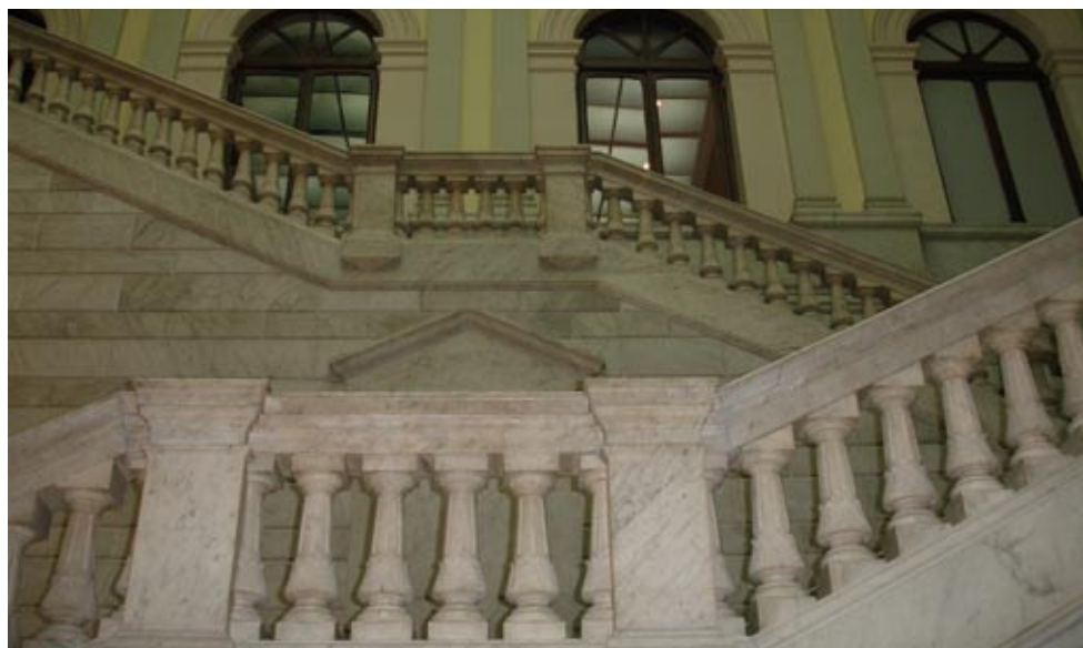
Escaleras de acceso en la entrada principal.
