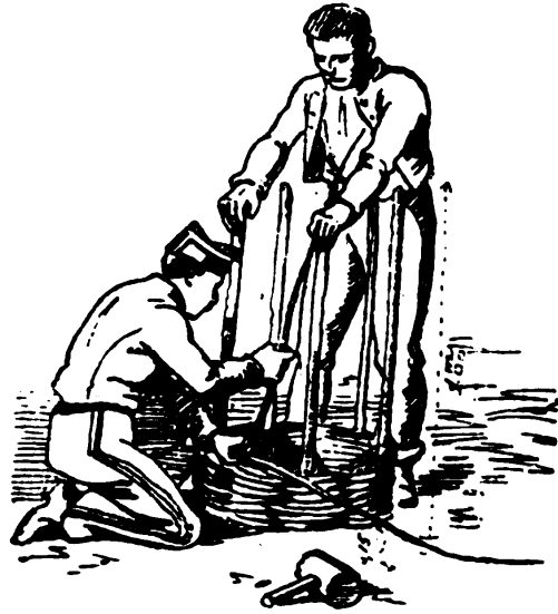
Zapadores construyendo un cestón.
