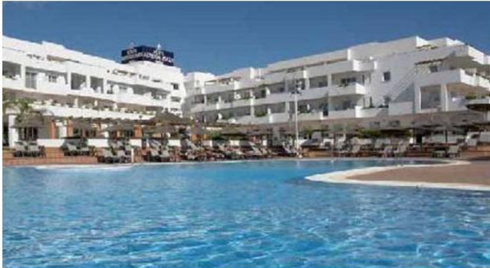
El hotel CaboGata Plaza Suites de Almería.
