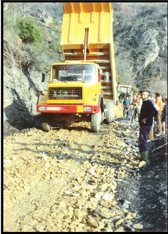
Fotografía 62. Camión trabajando en la apertura de la carretera.
