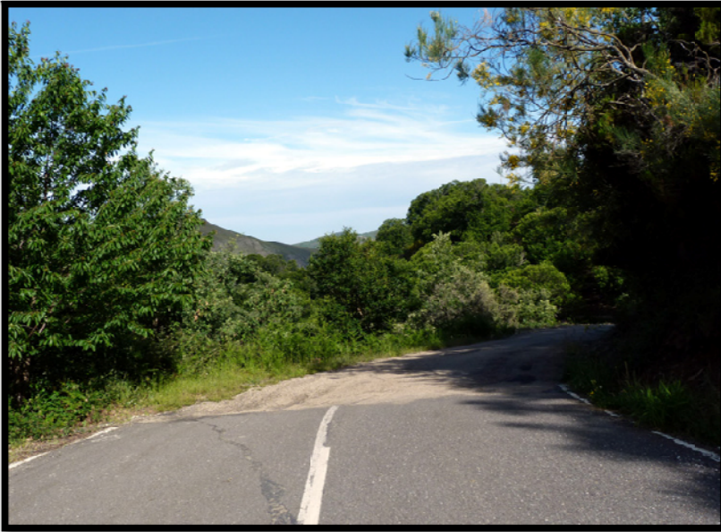
Fotografía 14. Detalle de la carretera entre Vega de Espinareda y Burbia (06-2012)
