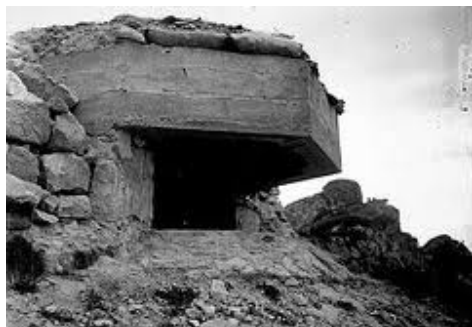
Bunker del Cinturón de Hierro
