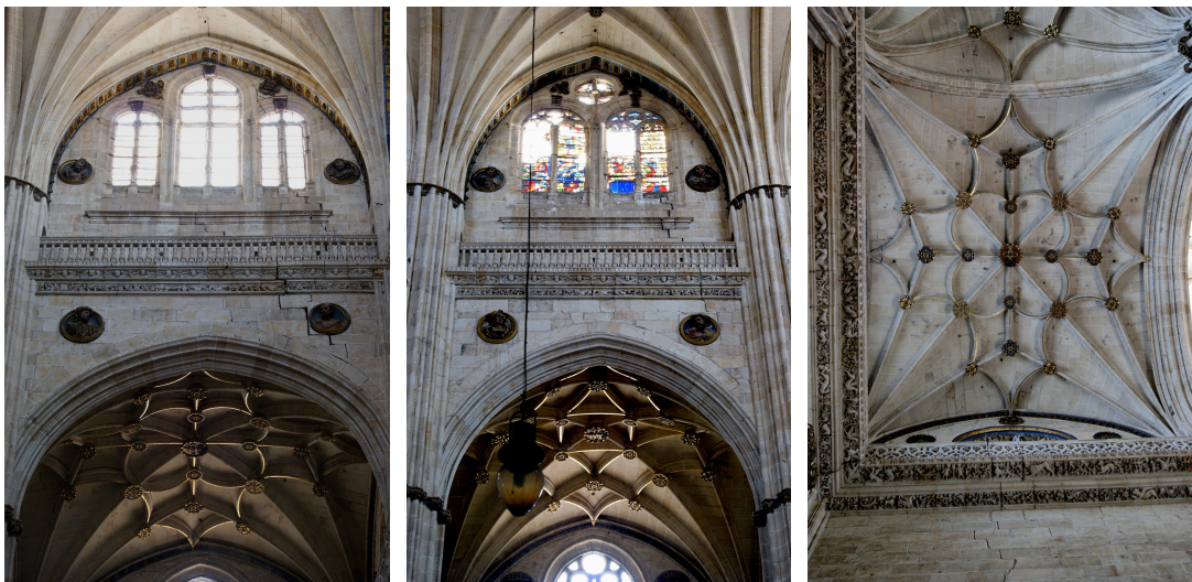
Fig. 51. Modelo de ventana de triple vano de la nave central
