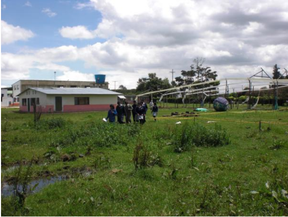
Colegio construido en el área del Humedal Gualí.
