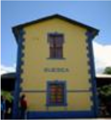
Estación ferroviaria –Suesca.
