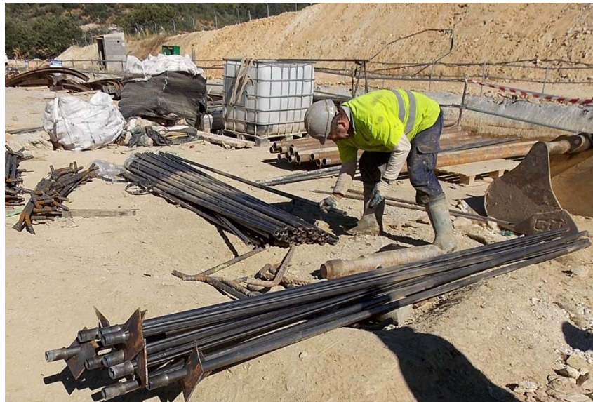
Figura 1. Esquema de un anclaje (Jimenez Salas et.al. 1980) y bulones de fricción "Swellex" preparados para su colocación.
