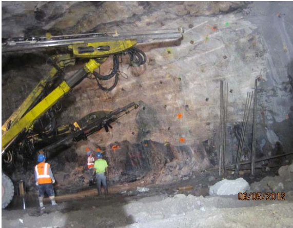
Figura 2.- Bulonado sistemático en el interior de un túnel (izquierda). Zona de compresión (sombreada) que se genera en la roca fracturada y que forma un arco autoportante (Hoeck et al. 1993).
