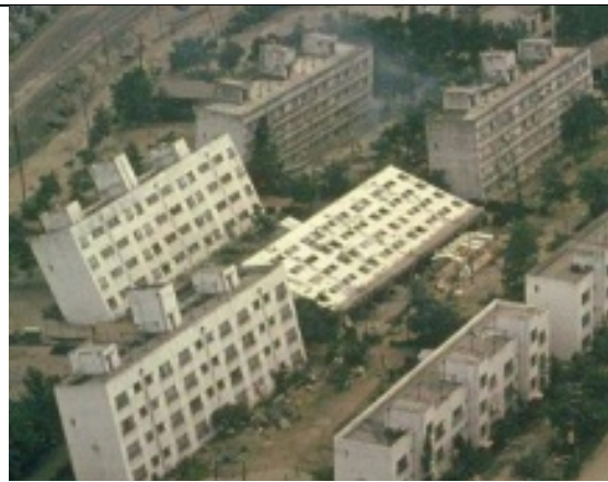
Fotografía 6. Fallo del cimiento de edificios en la ciudad de Niagata (terremoto de 1964).
