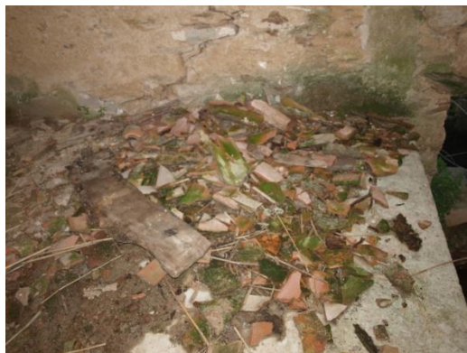
FIG.4.2.25. Imagen de la caída de elementos de cubierta.
