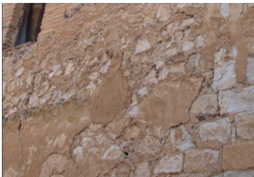
FIG.4.2.3. Imagen erosión de material en el material pétreo.
