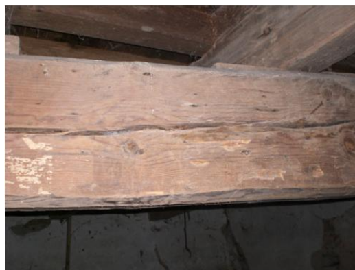
FIG.4.2.17. Imagen de las fendas en las vigas.
