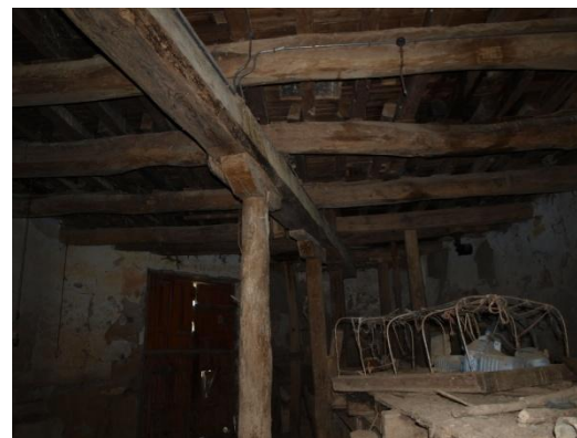
FIG.4.1.7. Fotografía del entramado de la planta primera de la fábrica de harina.
