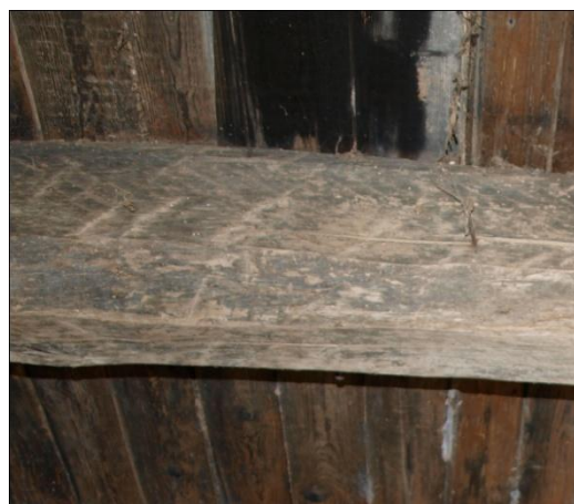
FIG.4.2.2. Imagen del ataque por insectos.
