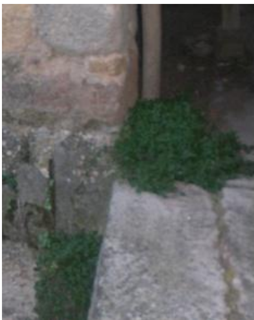
FIG.4.2.6. Imagen de organismos en las juntas de las piezas.
