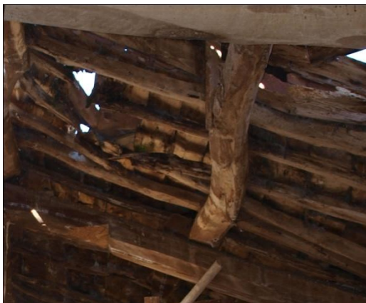
FIG.4.2.19. Imagen de los cabios en mal estado.
