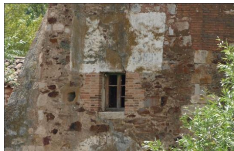
FIG.4.1.2. Fachada principal de mampuestos de piedra y sillares.
