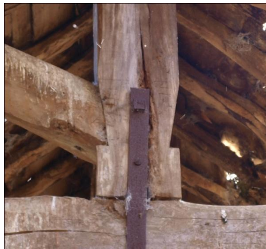
FIG.4.2.21. Imagen de la grieta en el pendolón.
