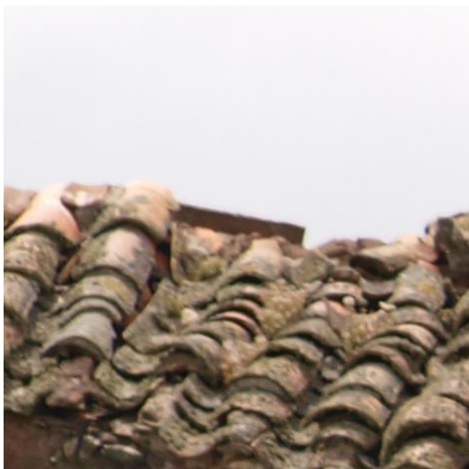
FIG.4.2.24. Imagen de la falta de elementos de cubierta.
