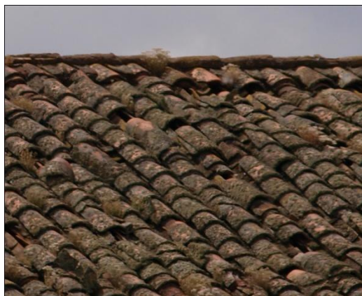
FIG.4.2.26. Imagen de la proliferación en el material cerámico.
