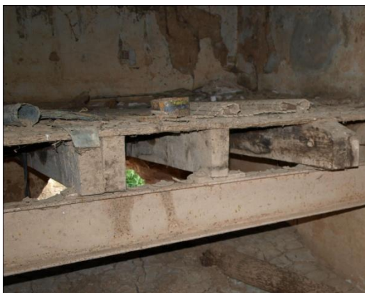
FIG.4.1.5. Fotografía del entramado de la plataforma de trabajo de la fábrica de harina
