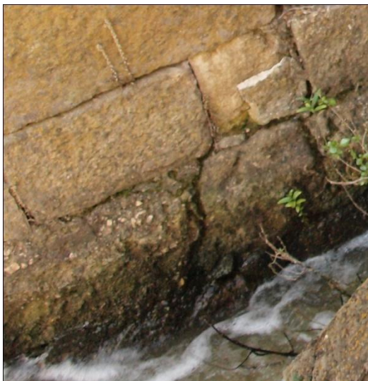
FIG.4.2.8. Imagen de humedad por capilaridad en los cerramientos.
