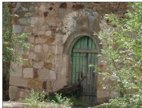
FIG.4.1.1. Fachada principal de sillares de piedra.
