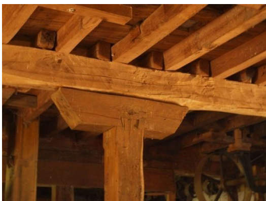
FIG.4.1.9. Fotografía del entramado de la planta segunda de la fábrica de harina.
