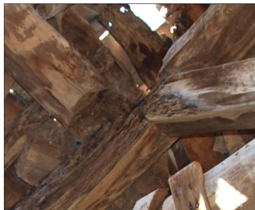
FIG.4.2.22. Imagen del fallo en el nudo de la cercha.
