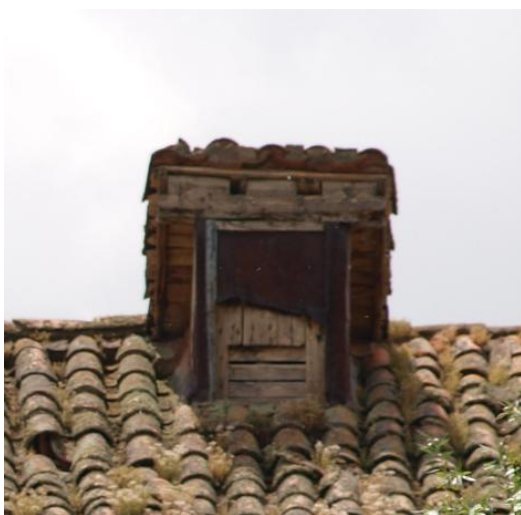
FIG.4.1.17. Imagen de la ventilación abuhardillada.
