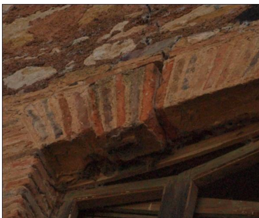
FIG.4.2.16. Imagen del descuelgue de las dovelas.
