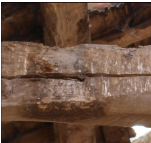
FIG.4.2.20. Imagen de la pérdida de sección resistente en el tirante de una de las cerchas.
