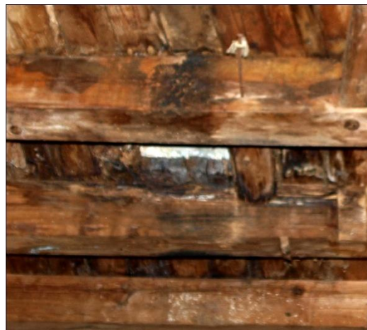
FIG.4.2.1. Imagen del ataque por hongos en entramados de madera.
