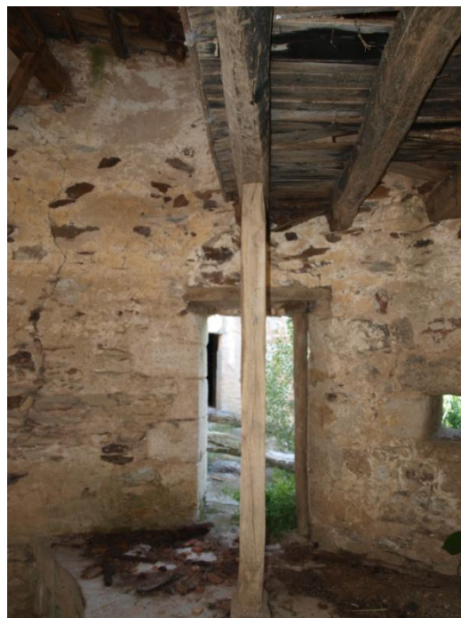
FIG.4.1.11. Fotografía del entramado de la plataforma de la aceña.
