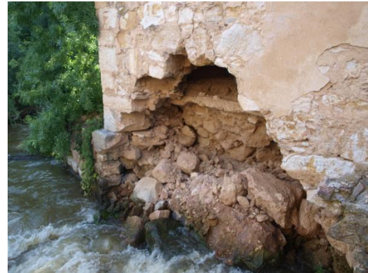
FIG.4.2.9. Imagen de desprendimiento en el arranque del muro.
