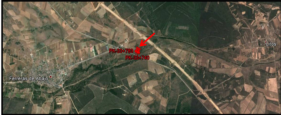
Imagen 3: Vista del punto de actuación referenciado con la ubicación de las localidades de Ferrerías de Abajo y Litos. (Google Earth)
