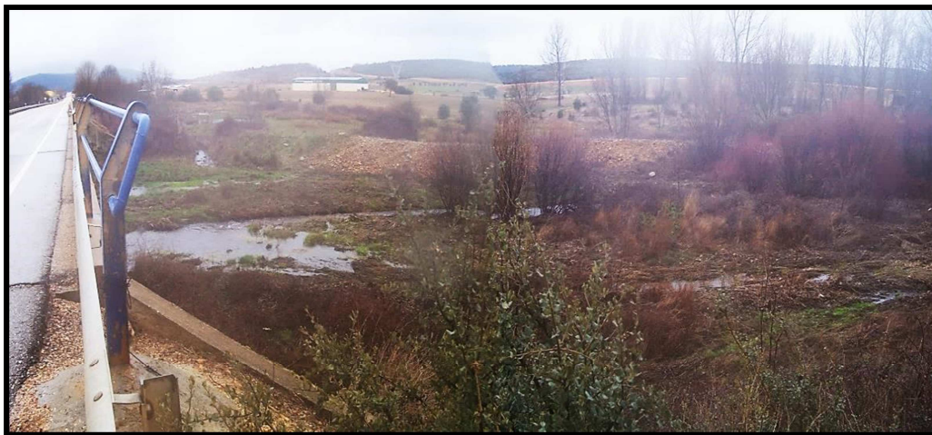
Imagen 6: Imagen aguas abajo del río Castrón sobre el margen derecho del puente que lo cruza en la N-631(02/2013)
