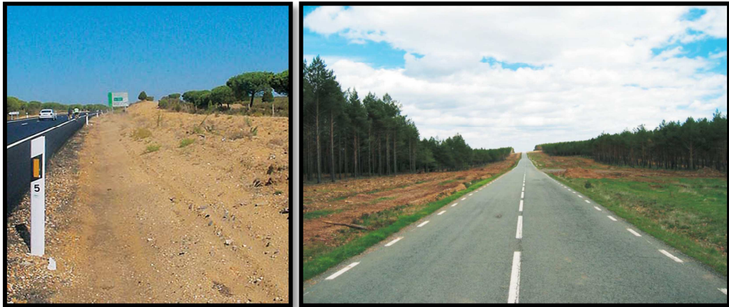
Imagen 6: Imágenes de desbroces, en carreteras convencionales, que se han llevado a cabo para aumentar la visión y el tiempo de reacción de los usuarios. (MIMAR)
