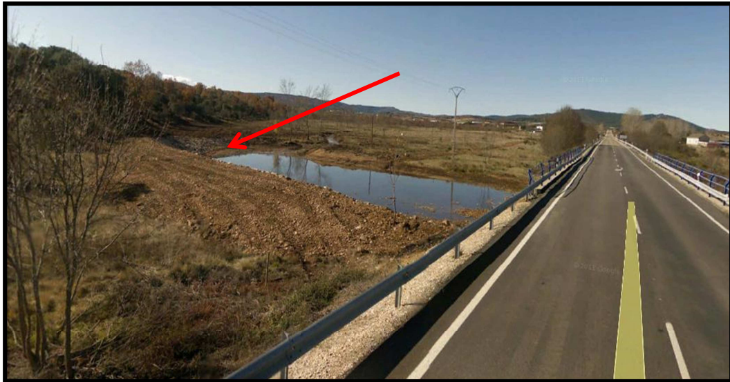
Imagen 7 y 8: Vista de escollera realizada sobre el margen derecho del río Castrón en la parte izquierda de la N-631. (Google Earth 07/2012)
