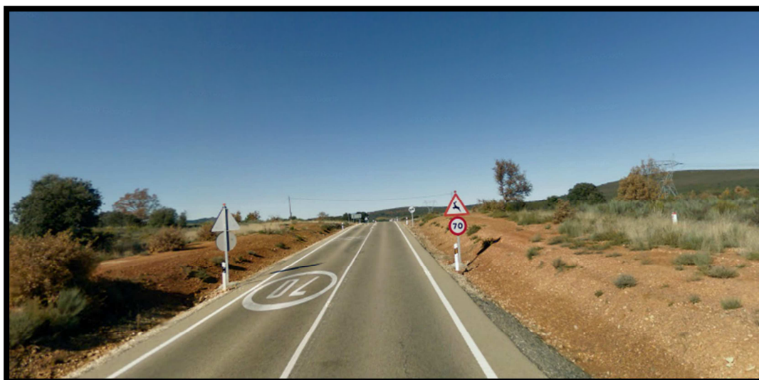
Imagen 8: Vista de la N-631 a la altura del PK-32+200 (Google Earth)
