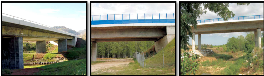
Imagen 17: Tres fotografías de viaductos acondicionados como paso de fauna. (MAGRAMA)
