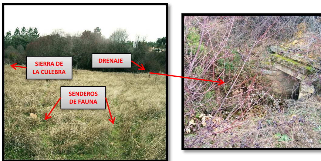
Imagen 11 y 12: A la izquierda: fotografía de senderos en las inmediaciones del arroyo de la Fontanona, por el margen izquierdo de la carretera N-631. Fotografía de la derecha: boca del drenaje. (02/2013)
