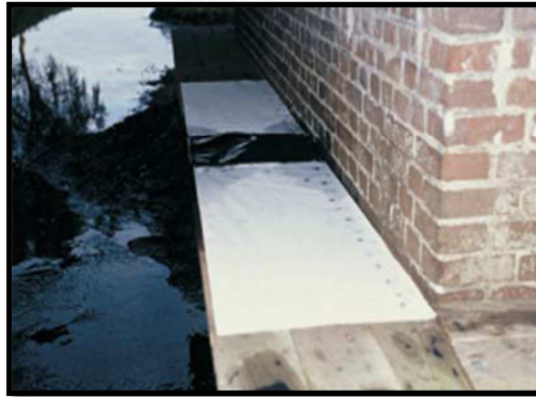
Imagen 4: Lechos de tinta situados en una plataforma para facilitar el paso de fauna a través de un drenaje.
