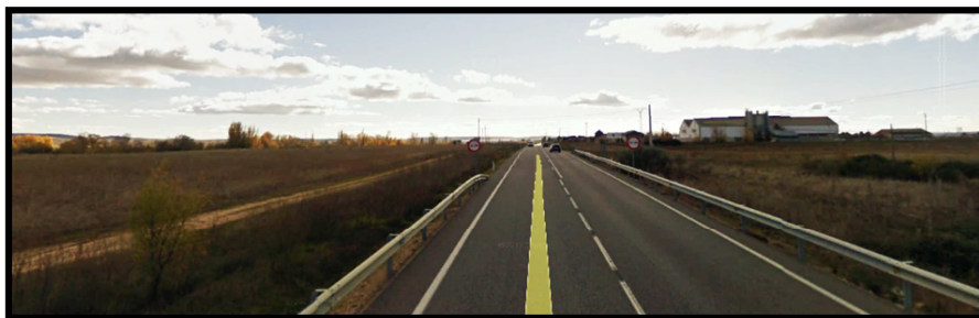
Imagen 5: Imagen de la carretera donde están colocados los reflectores de la imagen 4. Se aprecian los márgenes completamente despejados. (Google Earth)
