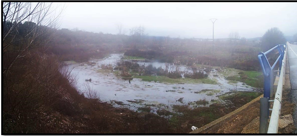
Imagen 5: Imagen aguas arriba del río Castrón sobre el margen izquierdo del puente que lo cruza en la N-631(02/2013)
