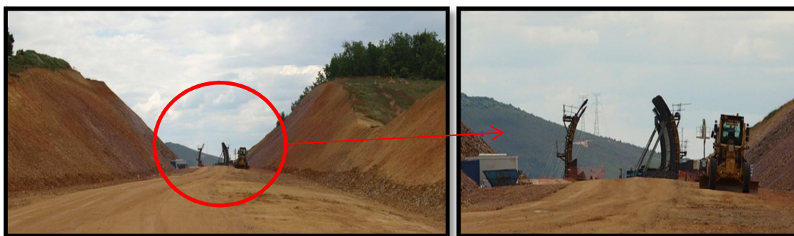
Imagen 4: Fotografías del ecoducto del AVE en la zona carretera ZA-P-1508, próximo al punto de actuación sobre la N-631. (5/2013)
