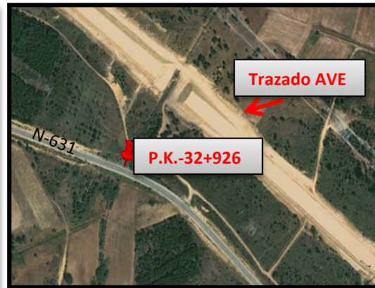
Imagen 3: Vista del punto de actuación en N-631 y trazado de las obras del AVE. (Google Earth-07/2012)
