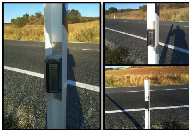
Imagen 4: Fotografías de los reflectores instalados en la M-103 a la altura del kilómetro 22. Talamanca de Jarama, Madrid. (10/2013)
