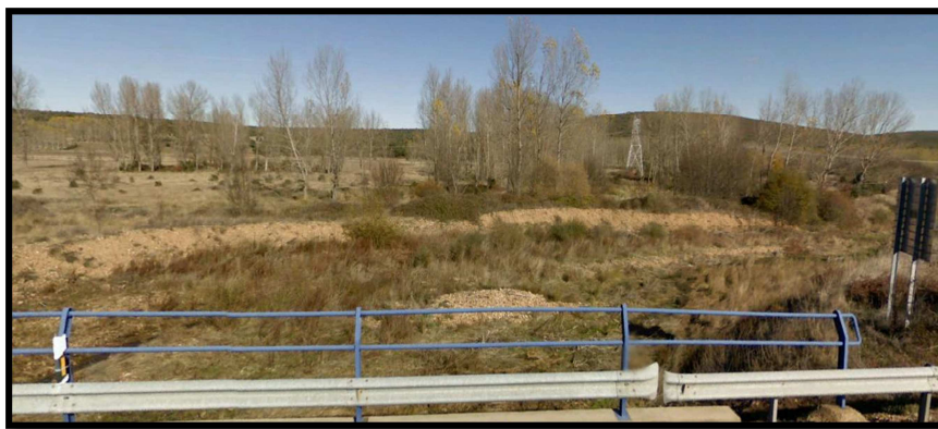
Imagen 9: Vista del margen derecho de la N-631 sobre el río Castrón donde se aprecia la escasez de vegetación de ribera y los ligeros desniveles perimetrales que encontramos en el terreno (Google Earth 07/2012)
