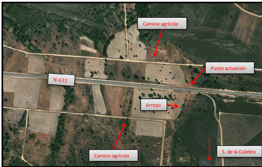
Imagen 17: Vista aérea de la N-631 referenciando el punto de actuación. (Google Earth 2013)
