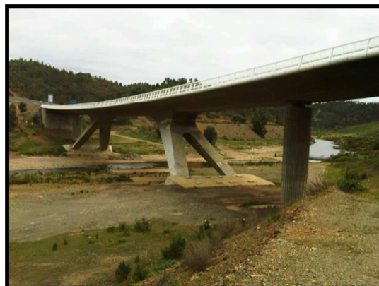
Imagen 17: Puente en la provincia de Huelva, sobre el río Chanza, en el municipio de Paymogo. Longitud 300 metros y ancho 13 metros. ( www.aopandalucia.es )
