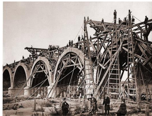
Charles Clifford, Construcción del puente de los franceses en Madrid . 1859
