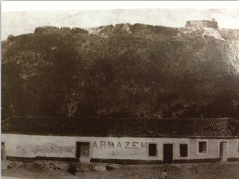
Foto 35 - Edifício como armazém de cereais em 1929
