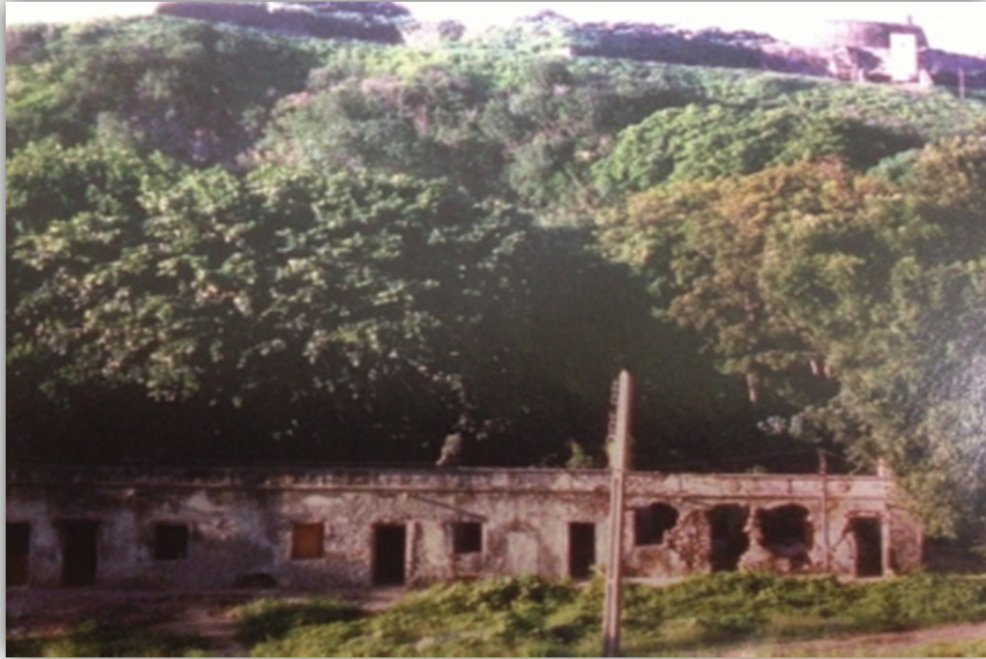
Foto 16 - Armazém em ruínas
