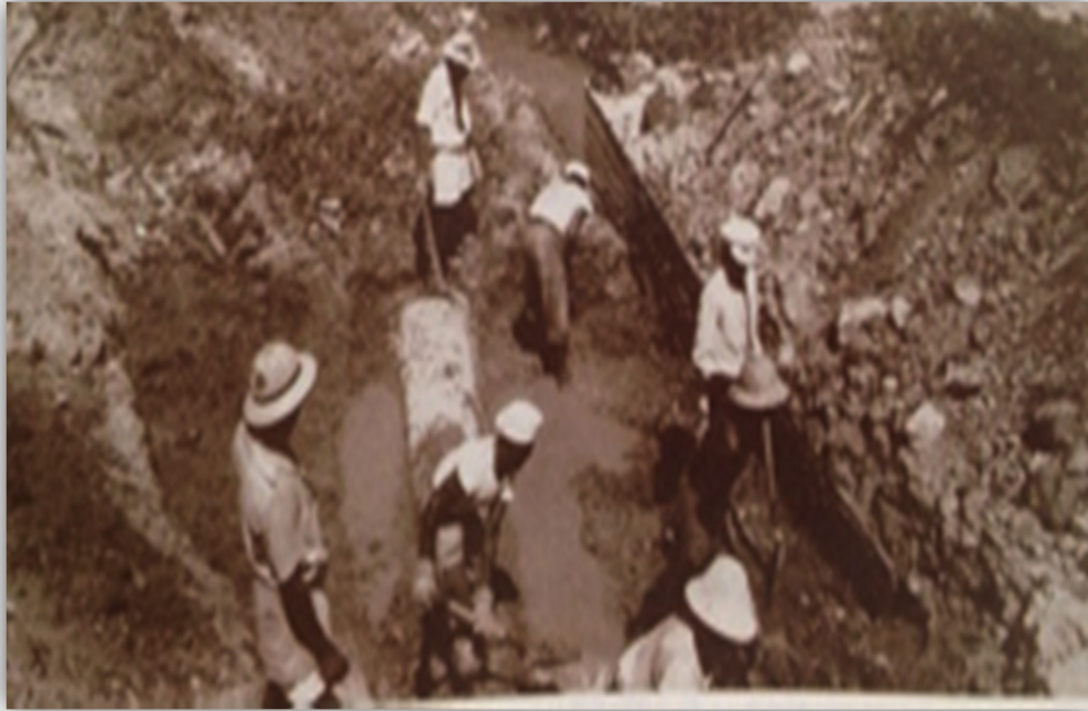
Foto 29 - Presos trabalhando na construção
