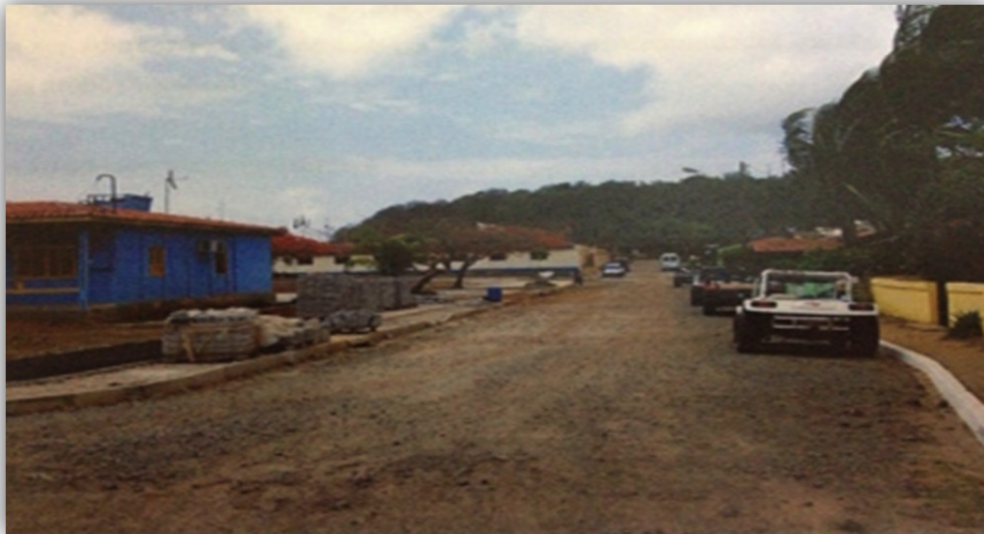
Foto 55 - Ruas mal asfaltadas em Floresta Velha
