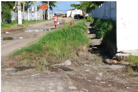
Foto 60- Lançamento de esgoto, Praia do Pilar.
