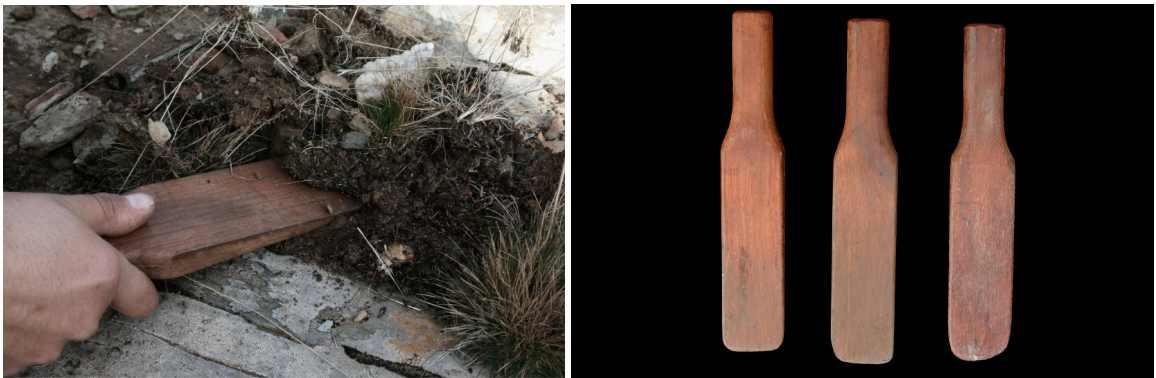
Ilustração 113 e Ilustração 114 - Fotos do processo de limpeza e espátulas de madeira usadas na limpeza das lajes
