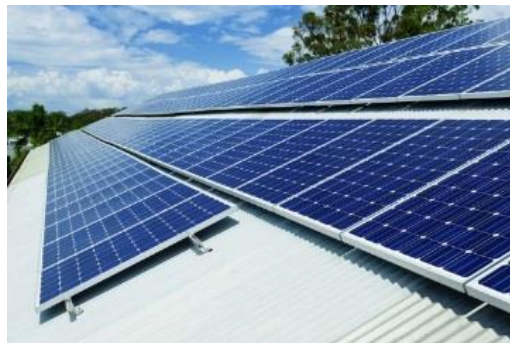
Ilustración 18: Placas instaladas sobre cubierta
