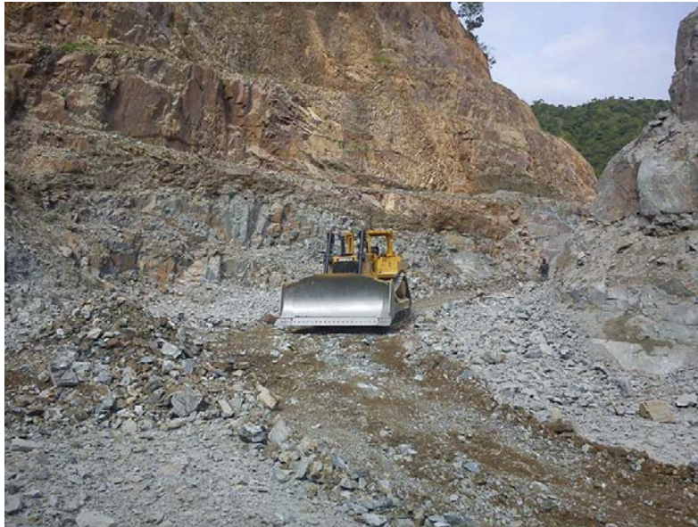
Figura 9. Obras de ampliación en una carretera al norte del país.
