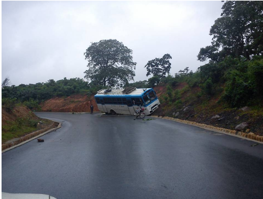
Figura 18. Autobús accidentado en una nueva carretera de Gujiland
