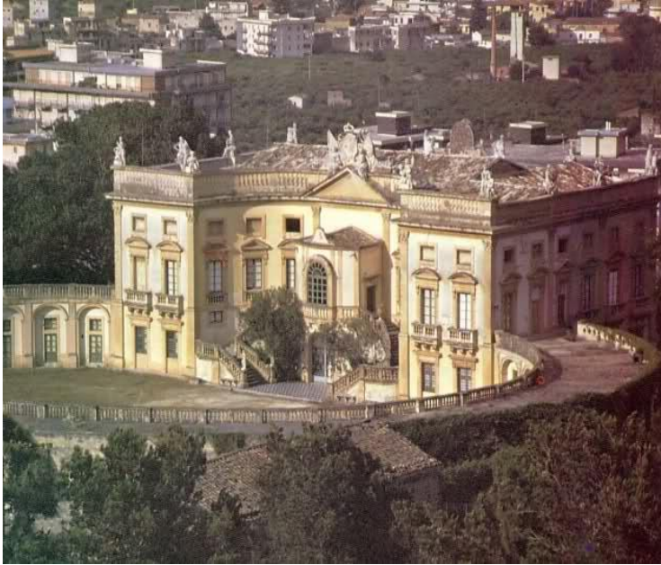
Villa Valguarnera, en Bagheria 28
