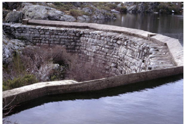
Muro de la laguna de Sotillo durante la fase de llenado de la cuedta en primavera
