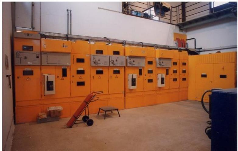
Figura 116: Cuadros de control y armarios de protecciones tipo
