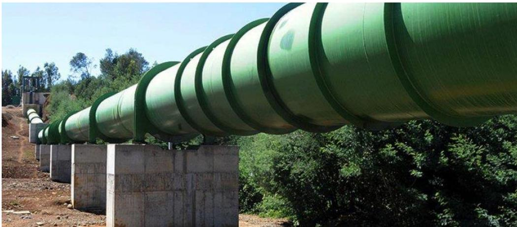
Figura 40: Tubería Forzada con anclajes de hormigón. Central Hidroeléctrica de la Isla de El Hierro (Canarias)
