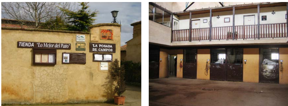
Figura 90. “La Posada de Campos” en Villamartín de Campos (Palencia). Entrada y patio/cuadra interior.
