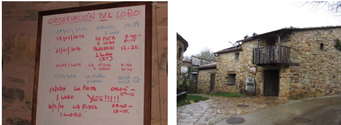
Figura 92. Centro de Turismo Rural “Veniate” en San Pedro de las Herrerías –Mahíde- (Zamora). Panel de observación del lobo y fachada exterior.
