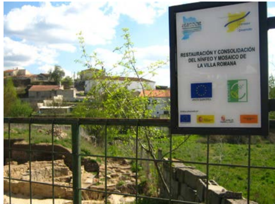
Excavación en la Villa Romana de Saelices el Chico (Salamanca)
