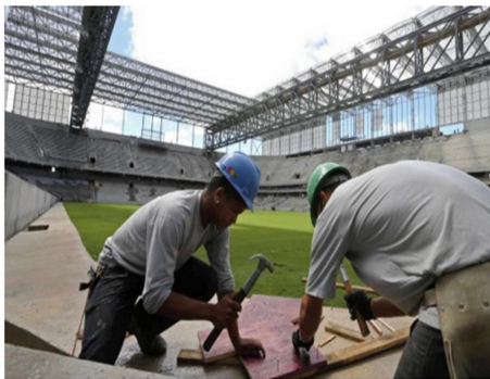
Operários trabalham nas obras da Arena da Baixada. / RODOLFO BUHRER (REUTERS)
