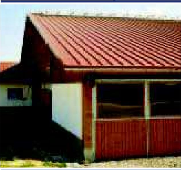
Panel metálico autoportante aislado en poliuretano destinado a las cubiertas inclinadas con pendiente mínima 3% en faldas sin sobreposición y 6% en faldas con sobreposición.
