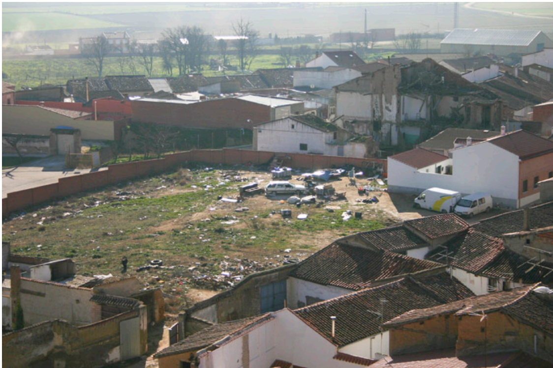
Plaza del Castillo [vista Sur]. Hundimiento de bodegas. Año 2012. Fotografía: José Manuel Rodríguez.
