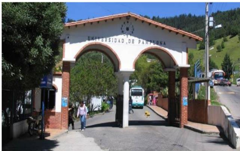
Figura 2.4. Entrada a la Universidad de Pamplona.
